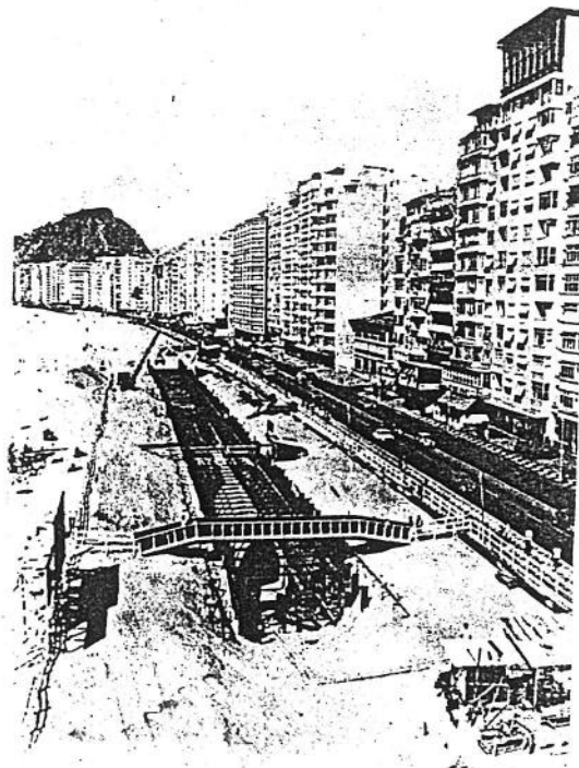
Obras de alargamento da Avenida Atlântica. Manchete, 1970.
