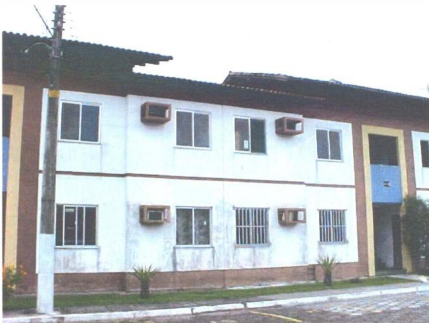
Figura 4.24 - Jaçanã: grades nas janelas. Fonte: Foto do autor, 2006.
