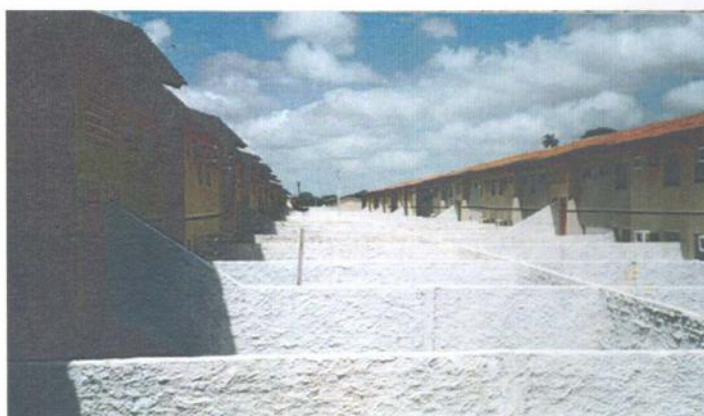
Figura 4.10 - Xavante II. Quintais com muros separadores (Foto tirada logo após a ocupação).
