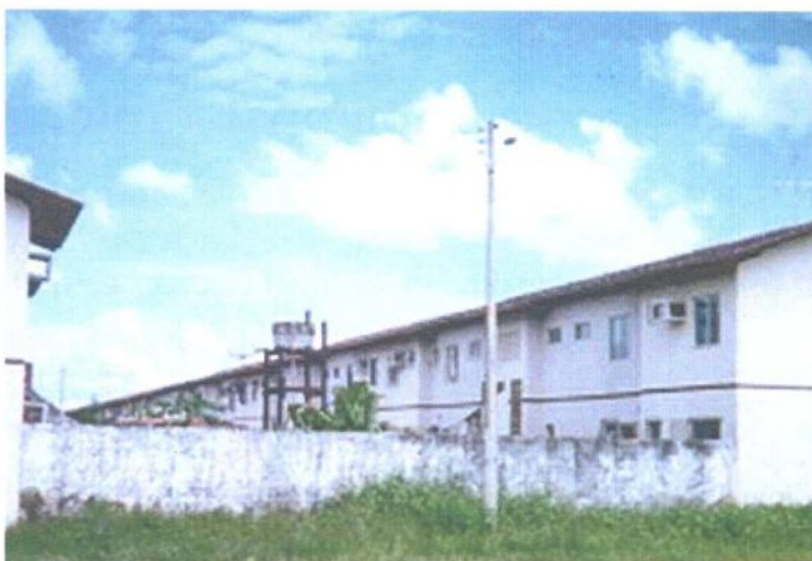
Figura 4.40 - Xavante II. Vista dos quintais com a interferência de um reservatório elevado em uma das unidades.
