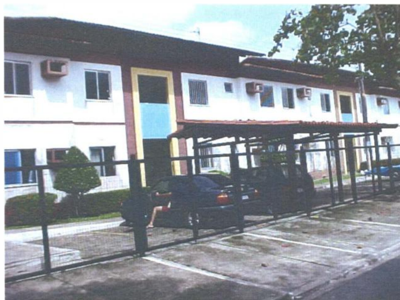
Figura 4.26 - Construção de coberturas em frente ao bloco virado para a rua. Fonte: Fotografia do autor.
