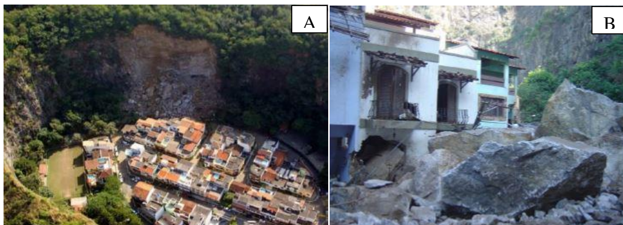
Figura 8 – Acidentes no RJ relacionados a queda de blocos: (a) Condomínio da rua engenheiro Gama Lobo, 650 (Brandão da Silva et al. , 2011). (b) Vila Isabel (Ribeiro, 2013).
