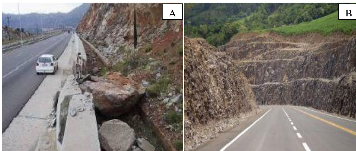
Figura 12– Proteção passiva: (a) Barreiras de proteção rígidas (Geobrug, 2012, apud Flórez-Gálvez, 2012). (b) Corte rochoso em banquetas (Flórez-Gálvez, 2012).
