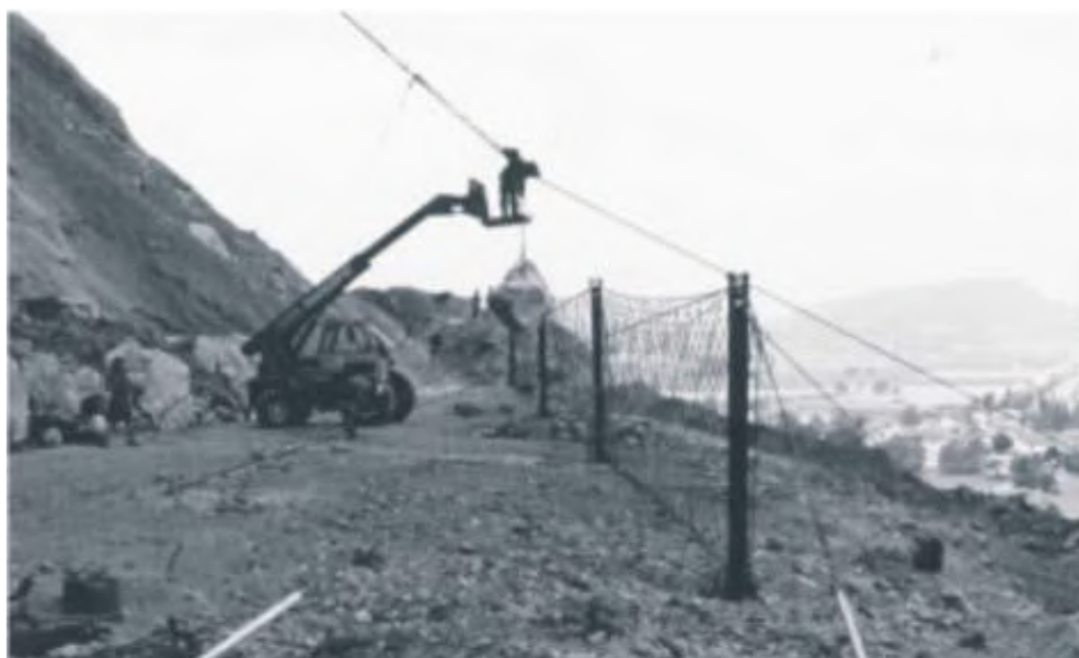
Figura 10– Exemplo de barreira de contenção com tela metálica (Peila et al. , 1998, apud Dias & Barroso, 2006).
