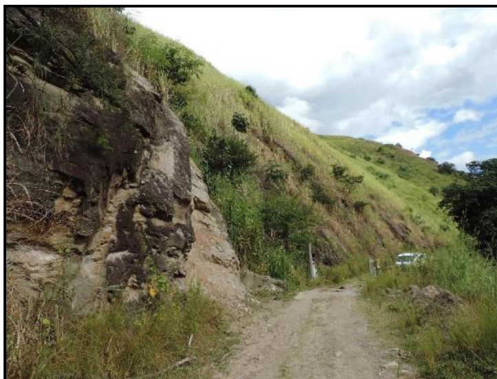
Figura 41: Ponto Javary1 de rocha muito alterada e ocorrências de deslizamento.
