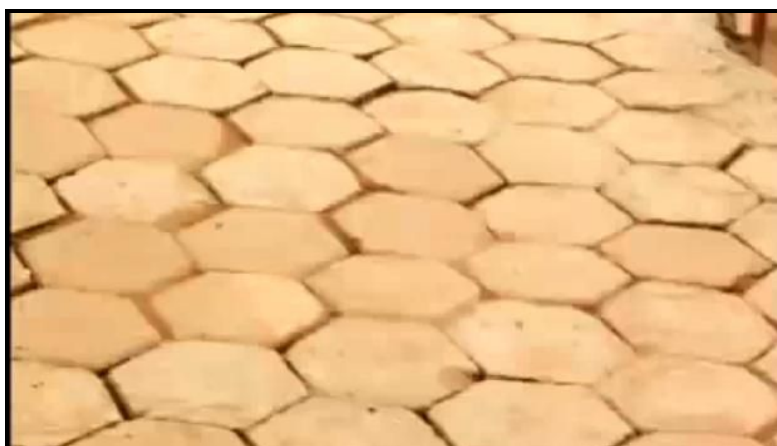
Figura 42 – Reaproveitamento das pedras de demolição para calçamento Fonte: Leroy Merlin , 2009[24]
