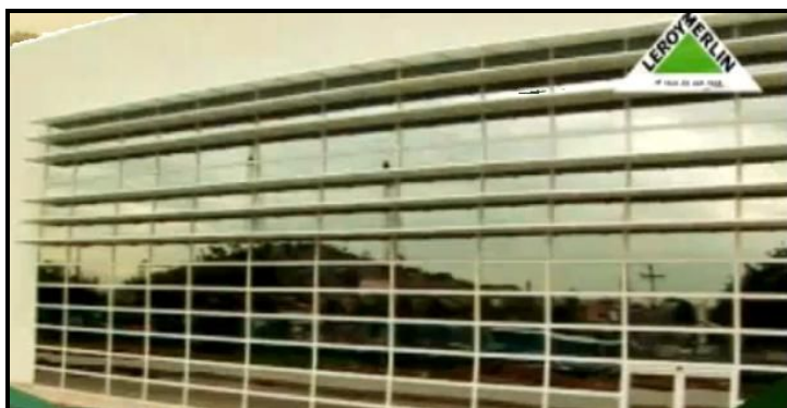
Figura 49 – Vidros e brises na fachada da loja - Fonte: Leroy Merlin, 2009
