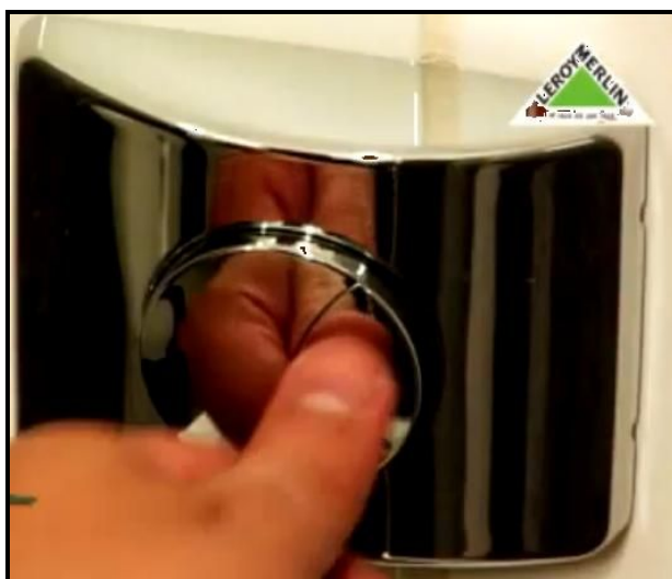
Figura 43 – Válvula de descarga com fluxo duplo
