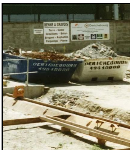
Figura 24 – Separação de resíduos de obra - Fonte: Ana Melhado, 2009
