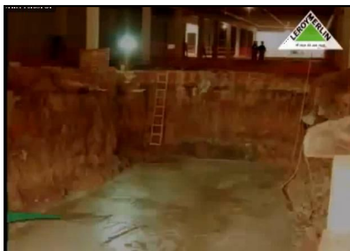
Figura 46 – Reservatório abaixo do estacionamento de 150 mil litros Fonte: Leroy Merlin, 2009
