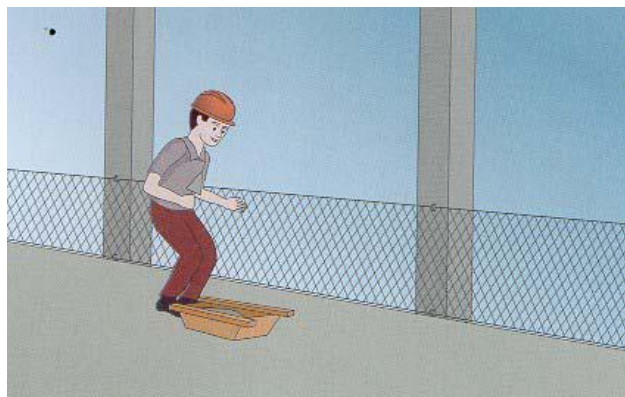
Figura 5 - Sistema de Barreira com Rede
