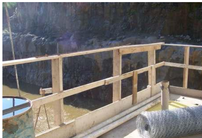
Figura 4 - GcR provisório de madeira Fonte: Proteções Contra Acidentes de Trabalho em Diferença de Nível na Construção Civil, 2005
