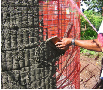
Figura 2.9: Construção do reservatório de alambrado para água pluvial (Fonte: SCHISEK, 2005)
