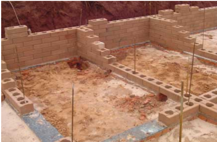
Figura 2.19: Obra utilizando o tijolo modular de solo-cimento (Fonte: TIJOLECO)
