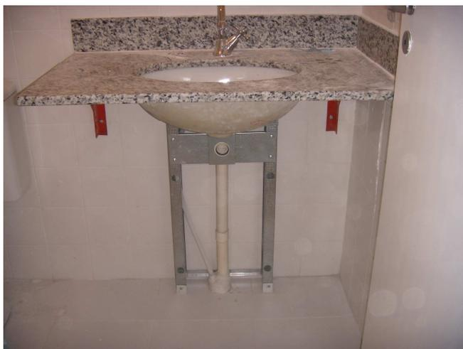
Figura 32: Plástico protetor preso em passante dentro de chassi do lavatório. Fonte: autora, 2008.
