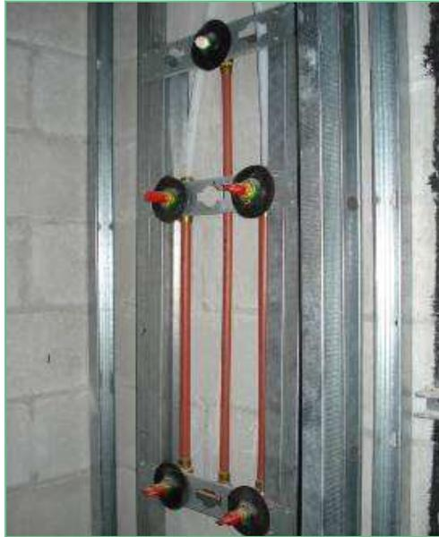
Figura 28: *Shaft* com apenas tubulações de PEX em seu interior. Fonte: autora, 2010.
