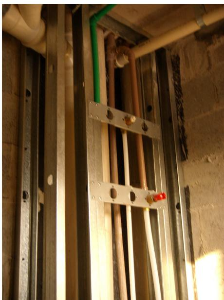
Figura 27: *Kit* chuveiro fixado nos montantes e tubo de PPR passando bem próximo ao montante do lado esquerdo. Fonte: autora, 2008.
