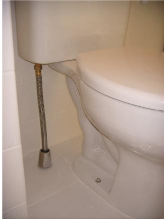
Figura 31: Acabamento metálico, borracha para acabamento de passante e plástico protetor. Fonte: autora, 2008.
