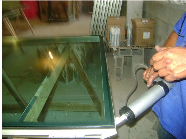
Figura 26 – Colagem dos vidros com silicone
