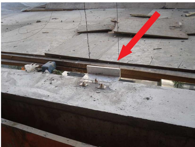
Figura 28 – Detalhe da ancoragem
