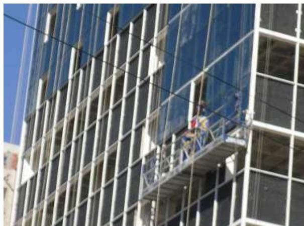
Figura 27 – Fixação do vidro na fachada
