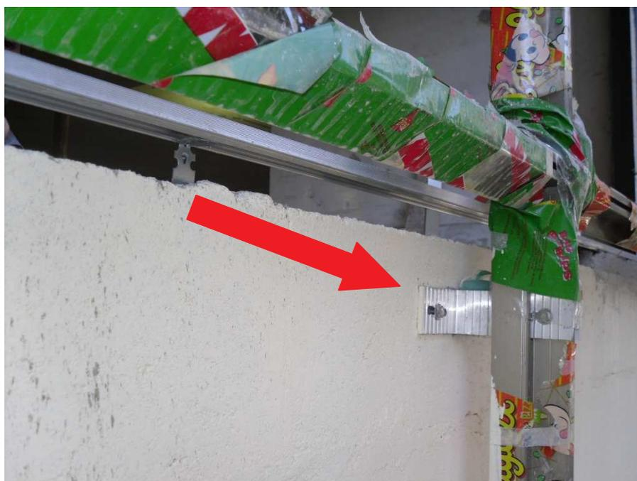
Figura 64 – Fixação da coluna na ancoragem
