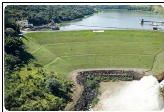
Figura 3.2: Usina hidrelétrica Euclides da Cunha [11].
