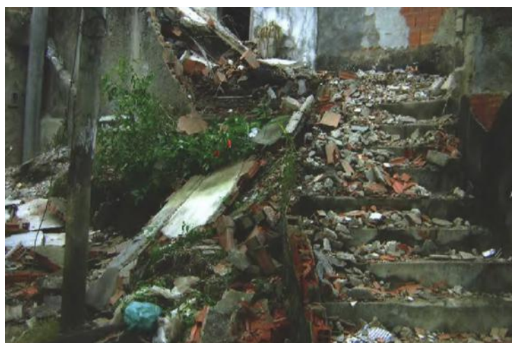
Comunidade da Estradinha após remoções e demolições.
