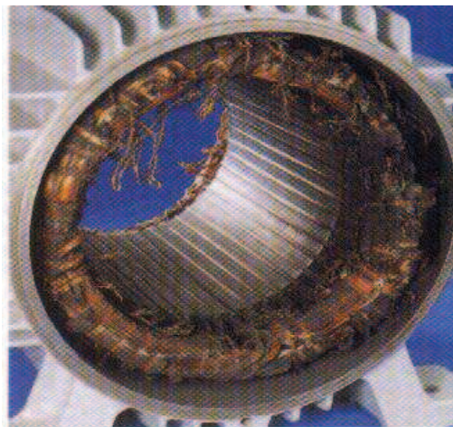
Figura 100 – Queima por Sobrecarga, Subtensão ou Sobretensões [44]
