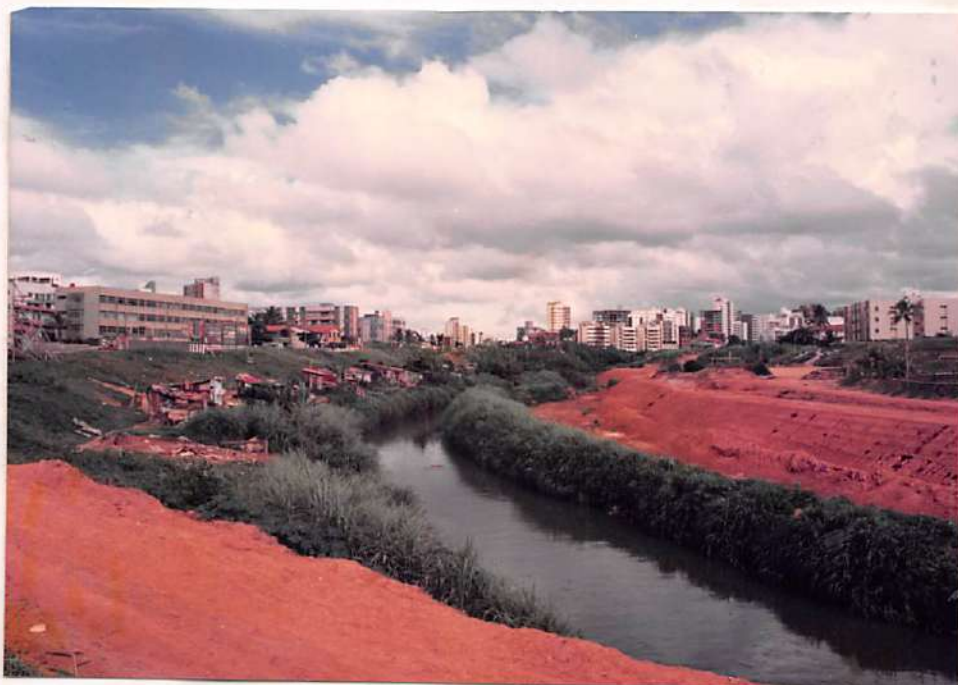
Paralisação das obras do Rio Camuruçipe em função do conflito estabelecido na área.
