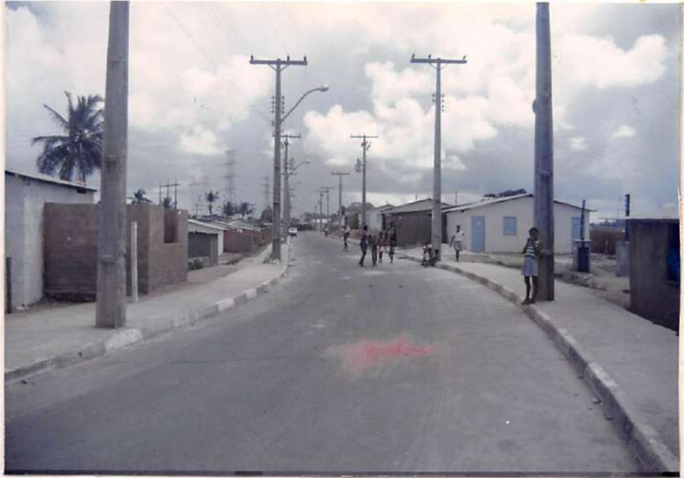
Única rua pavimentada do loteamento urbanizado do Beiru.
