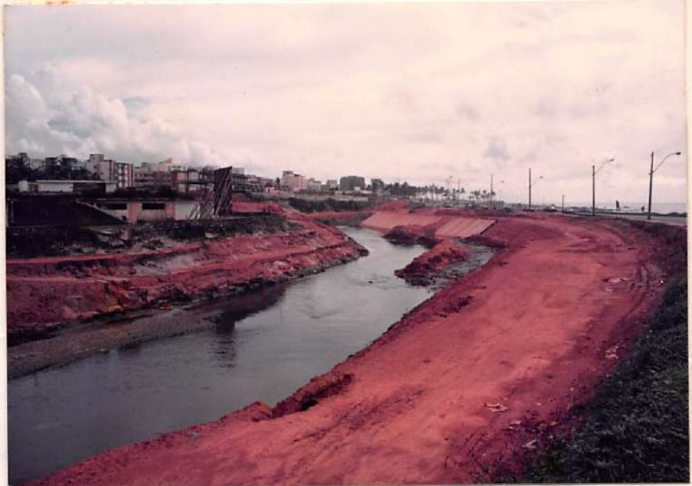
Projeto de drenagem do Rio Camuruçipe em andamento.
