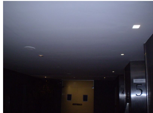
FOTO 4.4.6: 7º, bloco A
