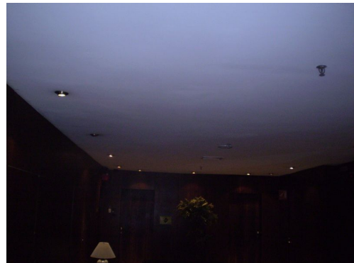
FOTO 4.4.2: 15º andar, bloco A
