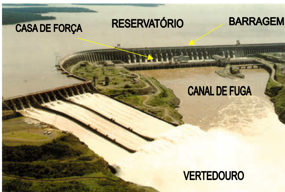
Figura 2.5 – Principais Componentes de uma Usina Hidrelétrica [23]
