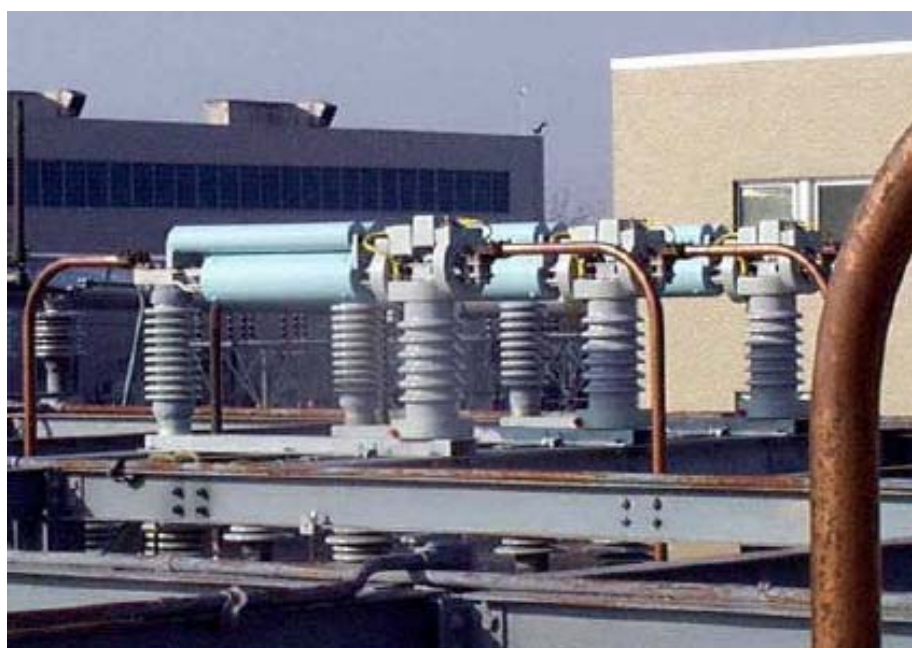
Figura 4.2 - Limitador de Corrente de Falta Pirotécnico da G&W Eletric de 38KV e 2500A [3]
