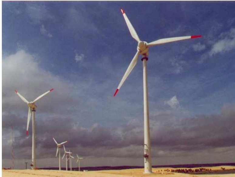
Figura 2.40 - Parque eólico conectado à rede – Parque Eólico da Prainha - CE
