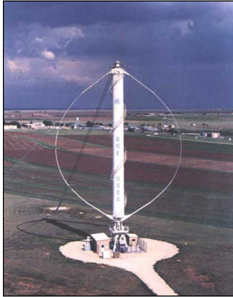
Figura 2.10 - Turbina eólica de eixo vertical de 34m de diâmetro projetada e instalada pelo SANDIA para testes na cidade Bushland, Texas (Fonte: SANDIA, 2000)
