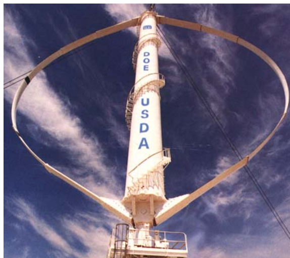
Figura 2.22 - Turbina experimental de eixo vertical (Fonte: SANDIA, 2006)
