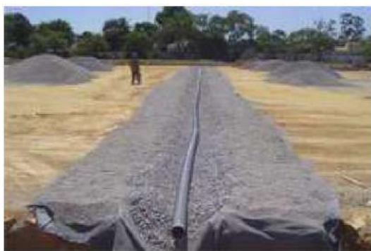
Figuras 2.23: (a) e (b) Trincheiras de infiltração – preparo e aspecto final
