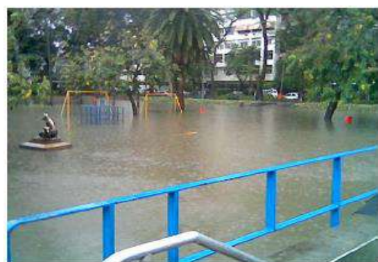
Figuras 2.22: (a) e (b) Praça Afonso Pena em dia ensolarado, e em evento chuvoso funcionando como reservatório de detenção
