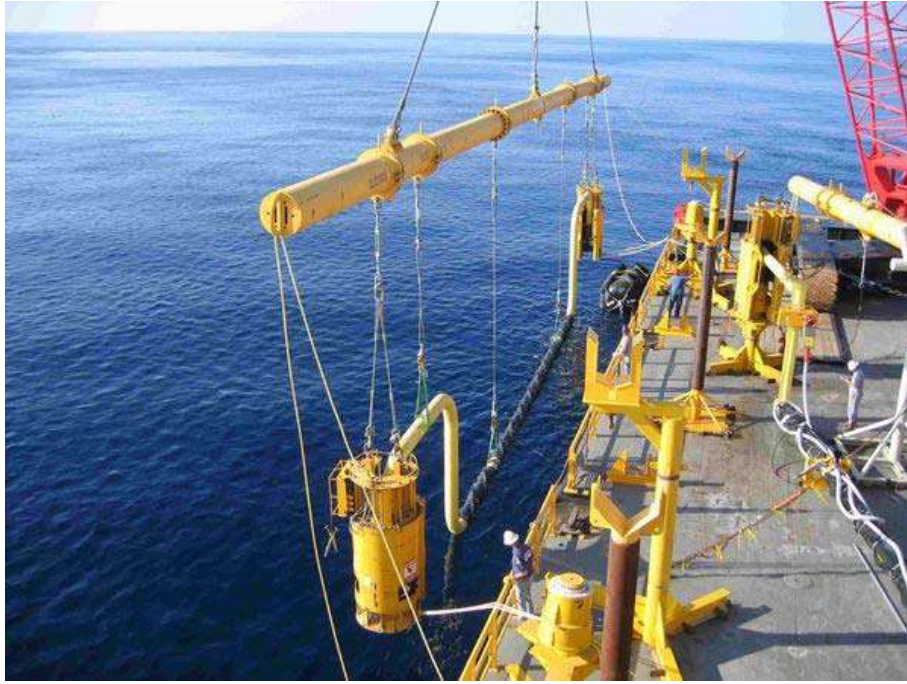
Figura II.3 – Exemplo de lançamento de jumper vertical com strakes [THECROSSGROUP, 2015].
