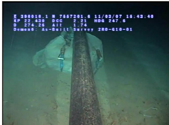
Figura 5.h) Vão livre corrigido com Grout Bag [20].
