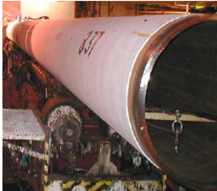
Figura 2.3 – Exemplo de duto rígido em processo de construção [7].
