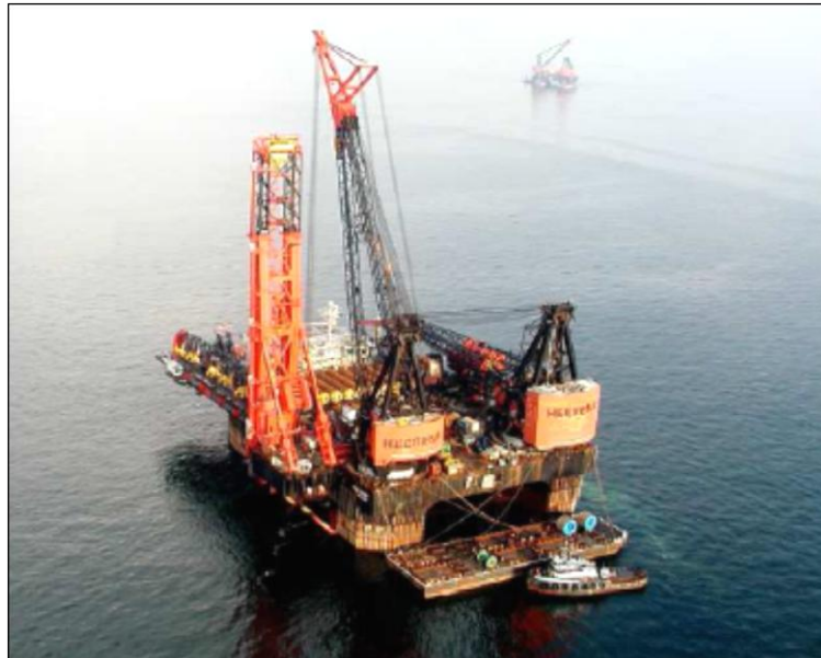
Figura 2.18 – Foto da balsa J-Lay Balder [13].
