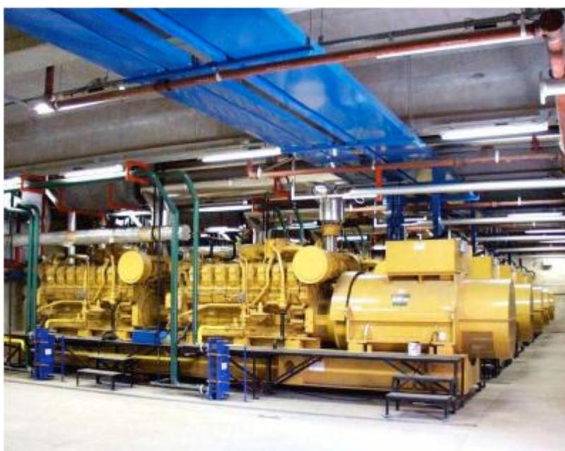
Figura 5.8 - Alguns dos equipamentos no interior da cogeração UGPU (5 motogeradores a gás)
