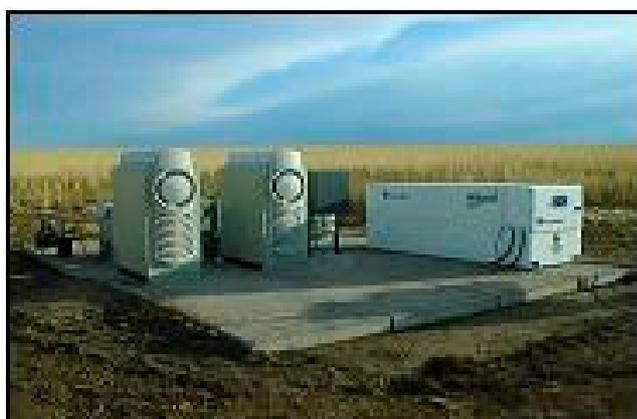
Figura 1.3 - Unidade de cogeração com microturbina a gás (exemplo de cogeração moderna)
