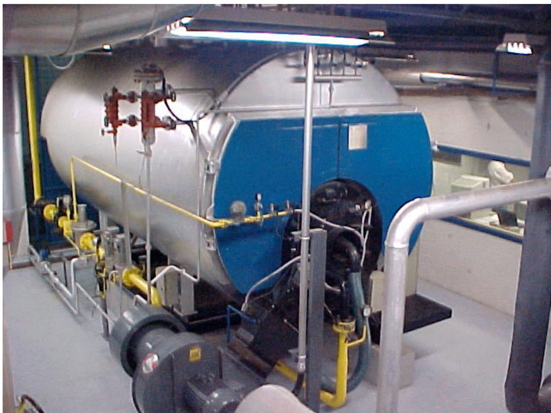
Figura 3.14 - Caldeira Auxiliar (do tipo flamotubular)
