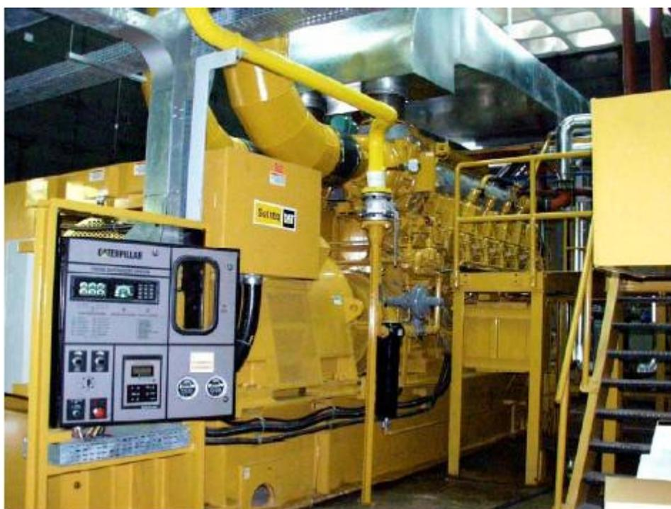
Figura 5.2 - Motogerador a gás, um dos equipamentos da cogeração Projac
