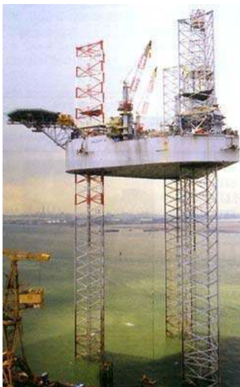
Figura II-12 – Plataforma auto-elevatória (SANTOS [8]).
