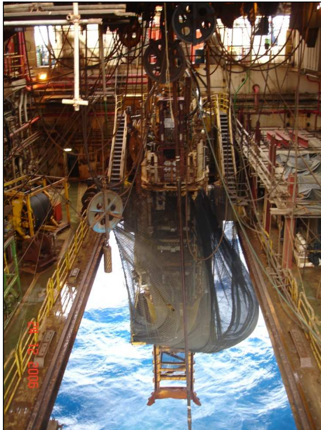
Figura 9.1.3 – Vista geral da LMRP e BOP.
