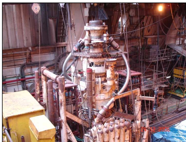
Figura 9.1.4 – Detalhe da BOP e da LMRP
