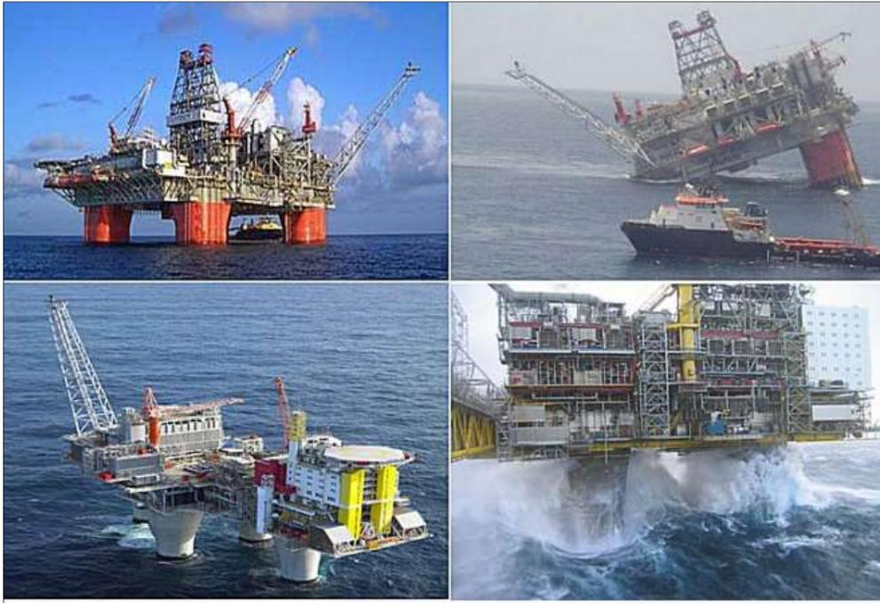
Figura 1.1. Danos causados por eventos naturais. Superior esquerdo: Plataforma de petróleo *Thunderhorse*, Golfo de México USA. Superior direito: Falha estrutural da plataforma depois da passagem do furacão Dennis (2005). Inferior esquerdo: plataforma de petróleo *Plata Heidrum*, Mar do norte, Noruega. Inferior direito: *Plata Heidrum* depois da passagem do furacão Oseberg (2007).
