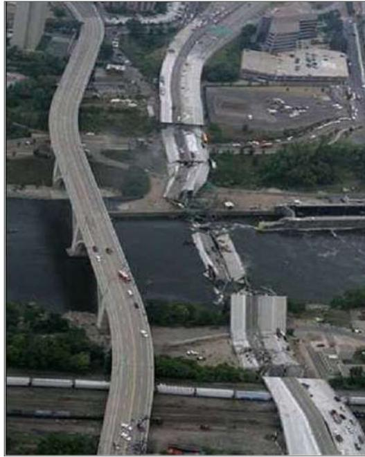
Figura 1.3. Ponte *I-35W* depois do seu colapso estrutural devido ao tráfego veicular (USA, 2007).
