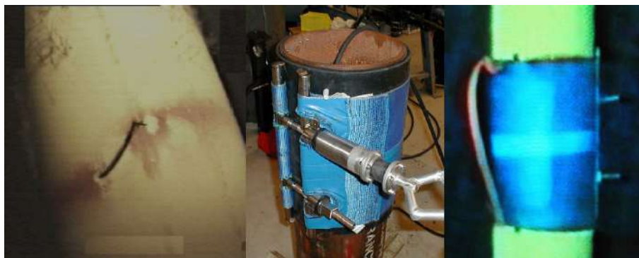
Figura 3.7: Reparo de capa com ROV. Reproduzido de MUREN [8], com autorização da Petroleum Safety Authority Norway .
