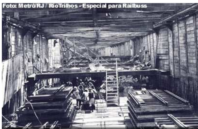
Operários na construção do Metrô, no Jardim da Glória. 1975.
