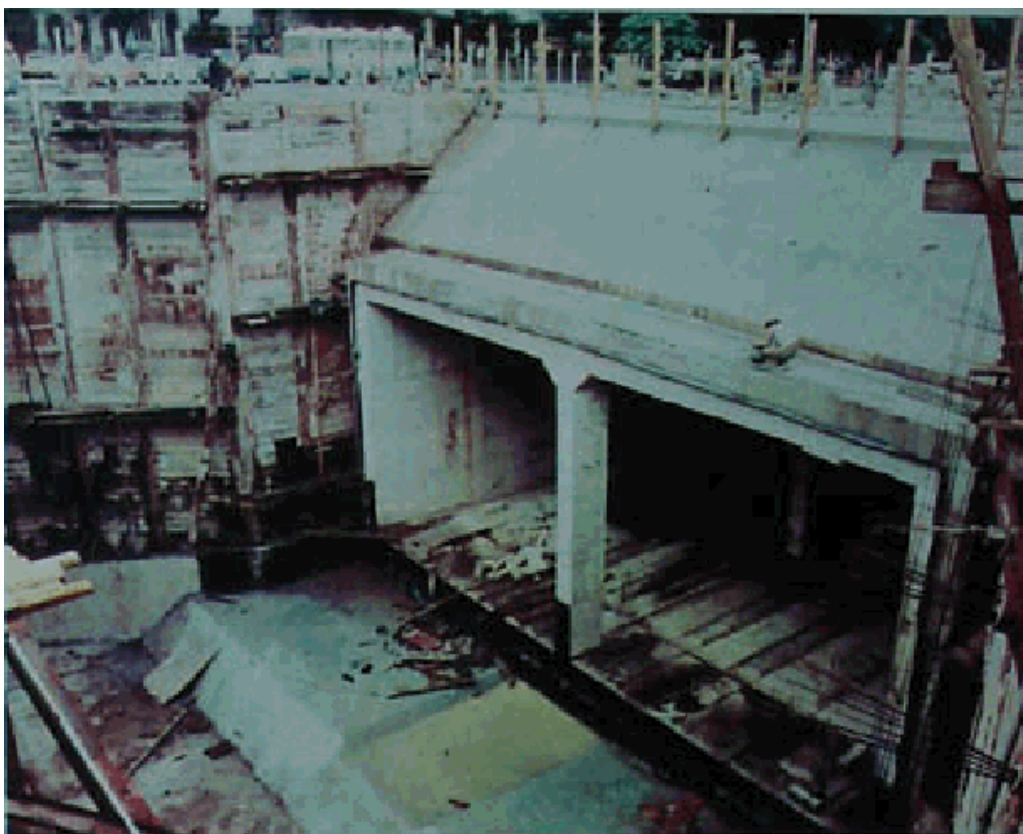
Figura 3.9 – Saída da galeria na estação da Glória
