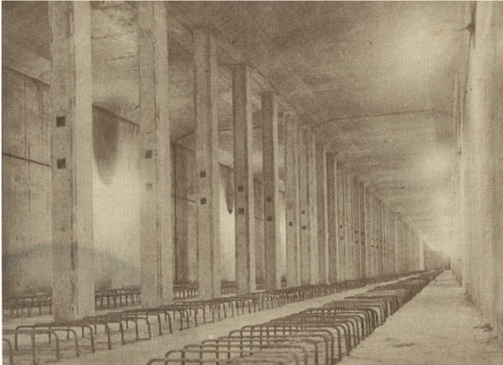
Figura 3.7 – Perspectiva interna da galeria do metrô
