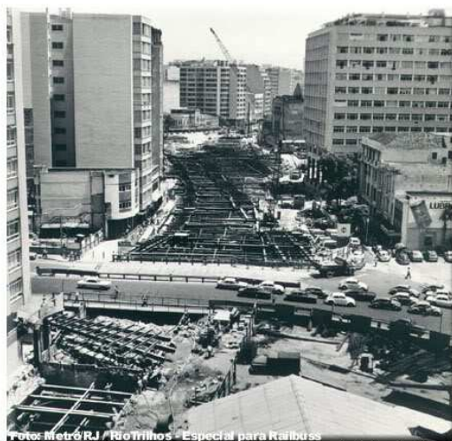
Obras da Estação Largo do Machado e trânsito nas ruas do bairro do Flamengo.
