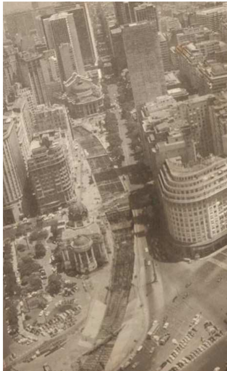
Figura 2.3 – Obras do metrô passando pela Avenida Rio Branco
