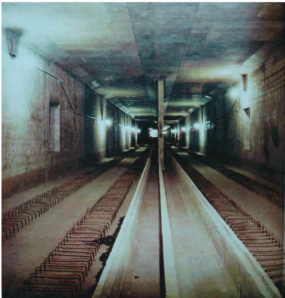
Figura 3.8 – Vista interna da galeria do metrô da Glória
