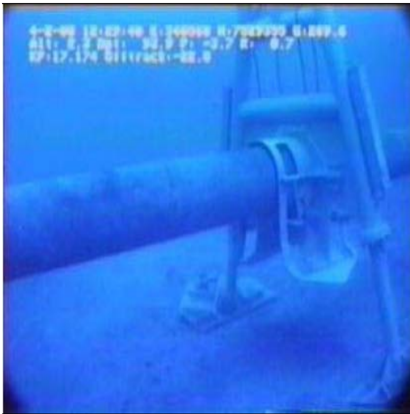
Figura 5 - Exemplo de suporte mecânico instalado no duto
