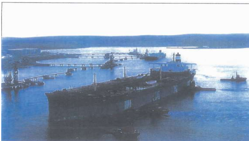
Figura 13: Rebocadores prestando assistência a navio-tanque no terminal de Sullon Voe, na Escócia.
