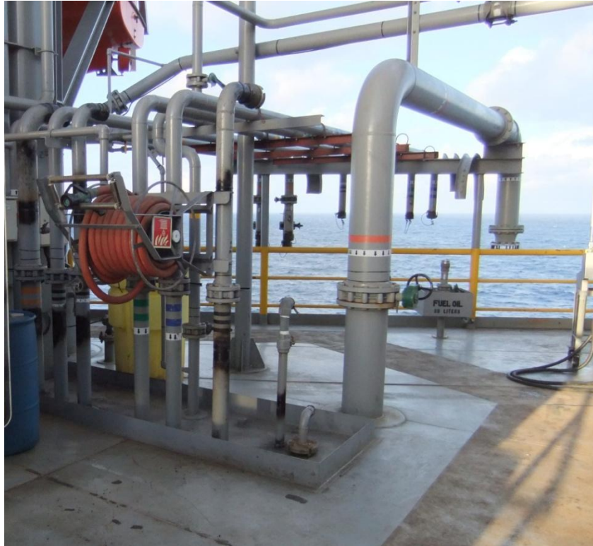
Figura IV.10: Estação de transferência de fluidos com os mangotes posicionados sobre o mar.
