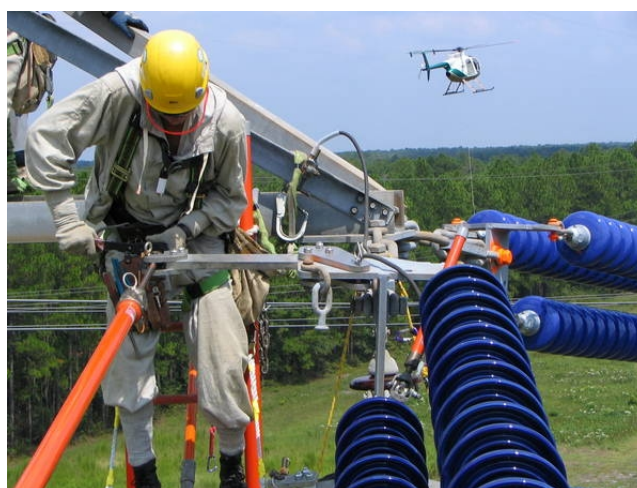
Figura 4.3 – Troca de isoladores em uma linha de 500 kV.
