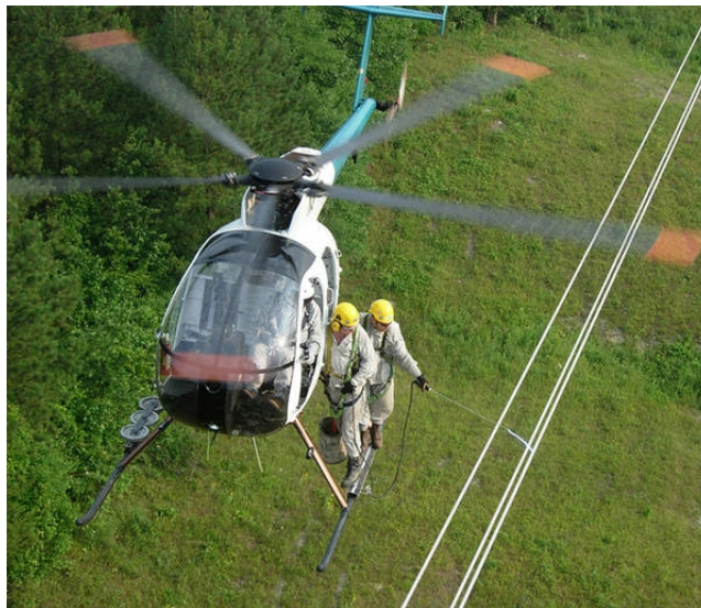
Figura 4.2 – Aproximação de equipe de manutenção em linha energizada.
