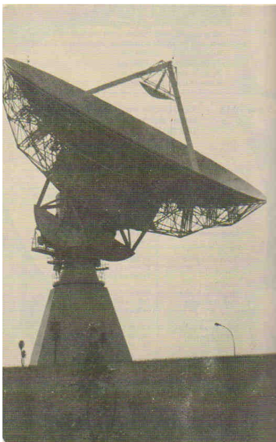
Fig. 2.26 – Estação terrena de comunicações via satélite, com 30 metros de diâmetro. Ref. [EMBRATEL]
