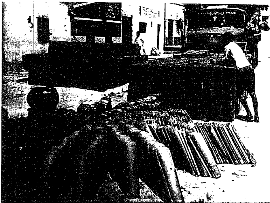
ENTREGA DO MATERIAL DE CONSTRUÇÃO À COMUNIDADE (V). PROJETO CAPITAL (1985)
