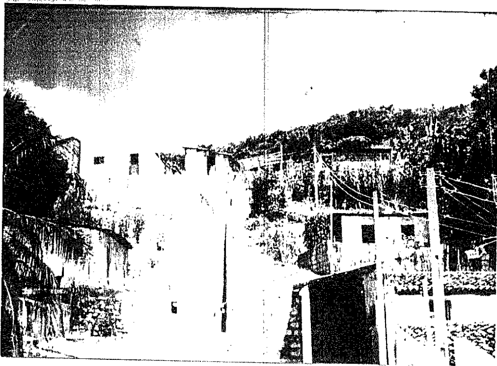
Acesso à Rua Alto da Colina.
