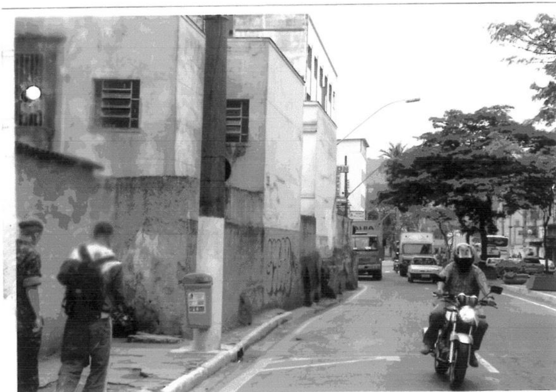
Foto 1: Avenida Independência, via obstruída por prédio Fonte: Processo Administrativo da Prefeitura de Juiz de Fora – MG – nº 7296/2006
