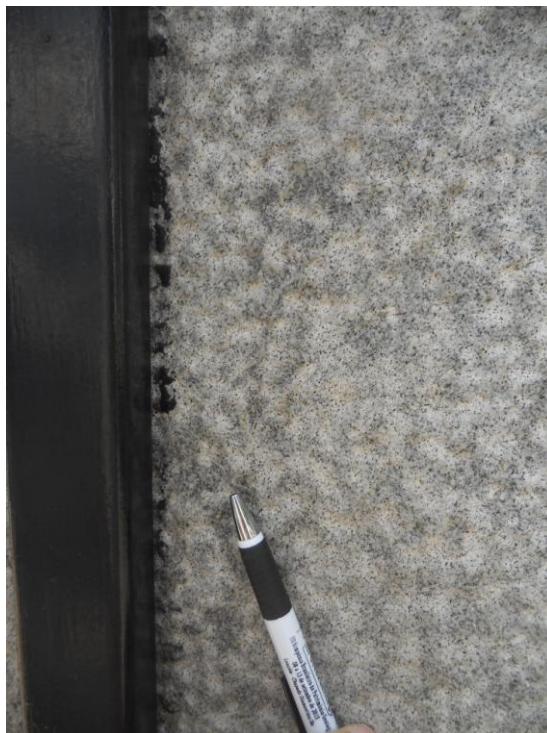
Figura 62. Manchamento de tinta e escurecimento das rugosidades "externas" do granito, causadas pelo picoteamento grosso utilizado no seu beneficiamento
