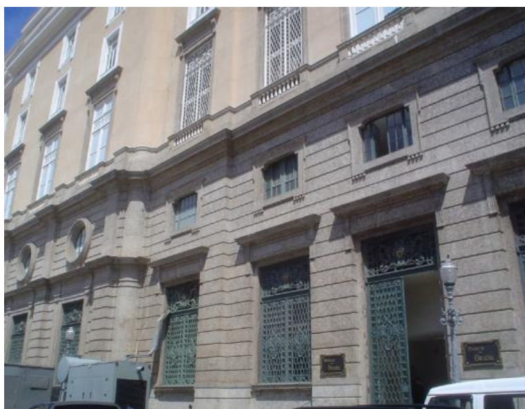
Figura 15. Fachada do Centro Cultural Banco do Brasil no centro do Rio de Janeiro em gnaiss facoidal. Fonte: Almeida & Porto Junior (2012)
