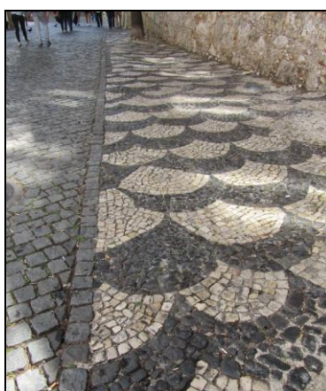
Figura 32. Primeira aplicação do calçamento com pedras portuguesas no Castelo de S. Jorge, Lisboa. Fonte: http://roc2c.blogspot.com.br/2015/04/sugestao-de-fim-de-semana-visite-o.html (acessado em 16 de fevereiro de 2016)
