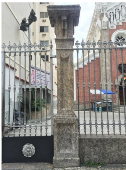
Figura 69. Pilastra da Basílica Nossa Senhora de Lourdes com alteração cromática amarelada ocorrendo na porção superior
