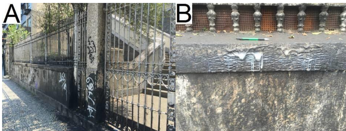
Figura 72. (A) Depósitos de coloração escura; (B) parafina de vela derretida em cima do muro
