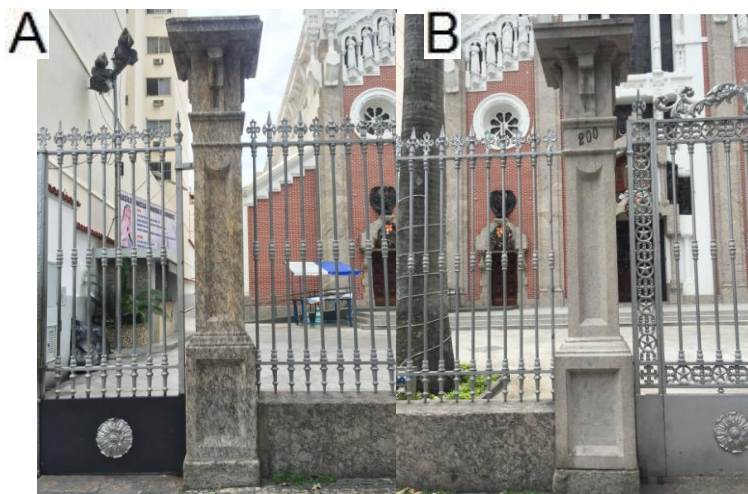
Figura 27. Colunas que compõem o portão de entrada da Basílica: (A) coluna de gnaisse facoidal; (B) coluna de granito
