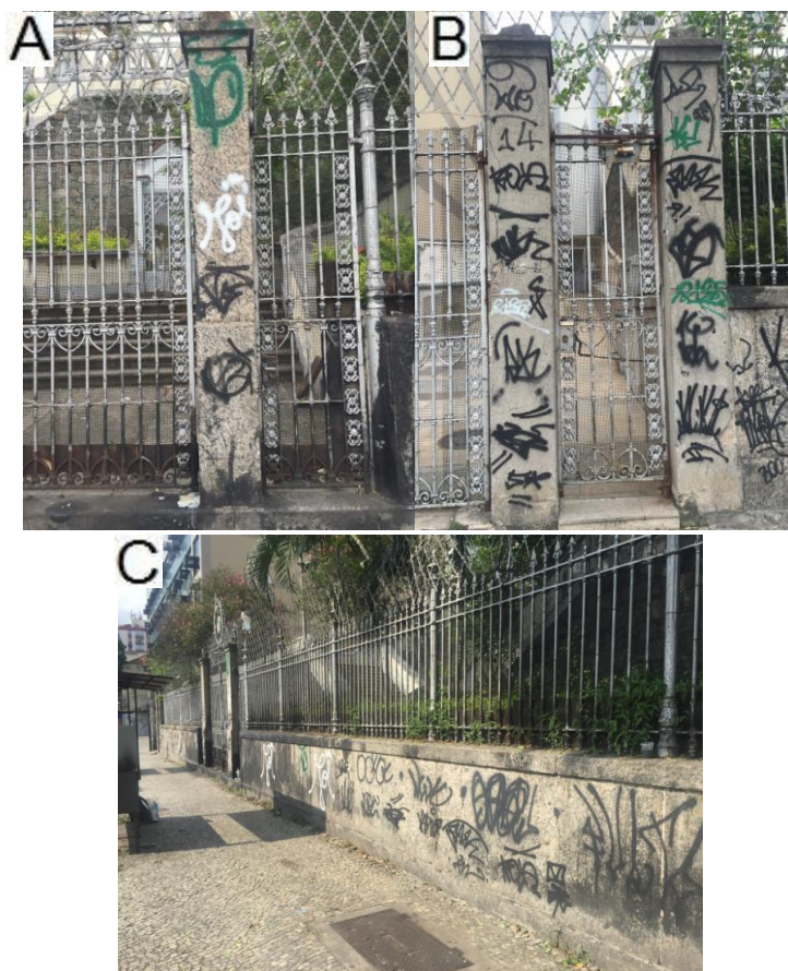
Figura 30. Fachada do Mosteiro: (A) coluna em gnaiss facoidal; (B) colunas de alvenaria; (C) muros e colunas em gnaiss facoidal
