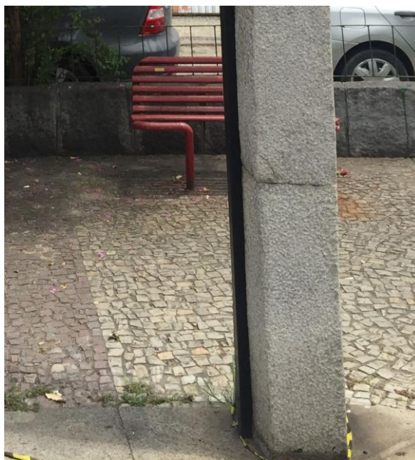
Figura 59. Perda de massa com restauro no bloco superior, perto do contato entre os blocos
