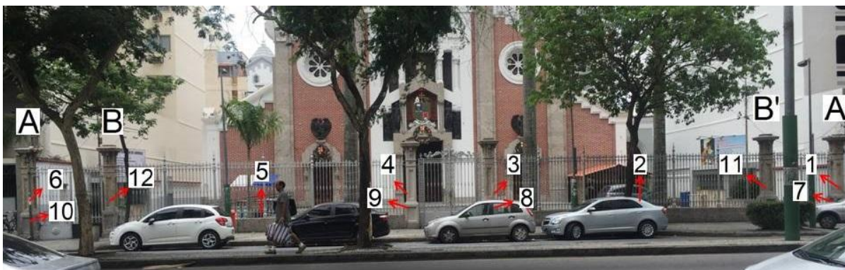
Figura 42. Distribuição de pontos e na Basílica de Nossa Senhora de Lourdes e orientação utilizada no mapeamento de danos
