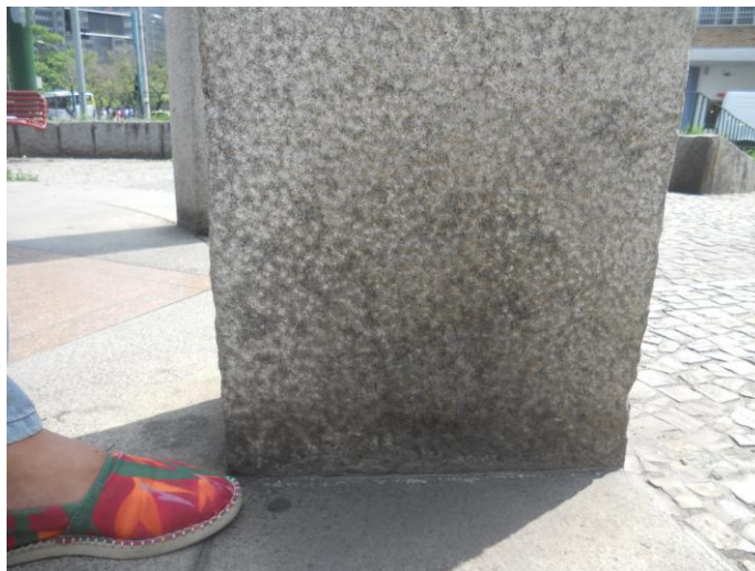
Figura 58. Depósito comumente encontrado na base das pilastras
