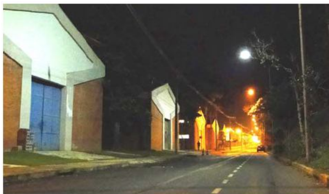
Figura 27 - Iluminação noturna de parte do anel viário com LEDs, em primeiro plano, e com VSAP, ao fundo [21].
