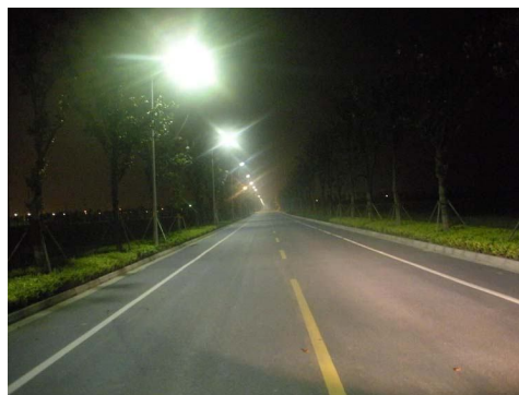
Figura 48 - Iluminação de rodovia com luminárias LED.
