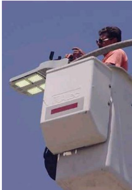
Figura 39 – Instalação de luminária LU6 de 90 W.
