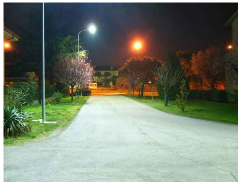
Figura 47- Projeto de iluminação de vias de acesso de um condomínio com a substituição das luminárias a Vapor de Sódio de 150 W, por luminárias LED de 60 W.
