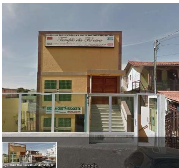
Figura 28 - Escola sem acesso ao telhado.
