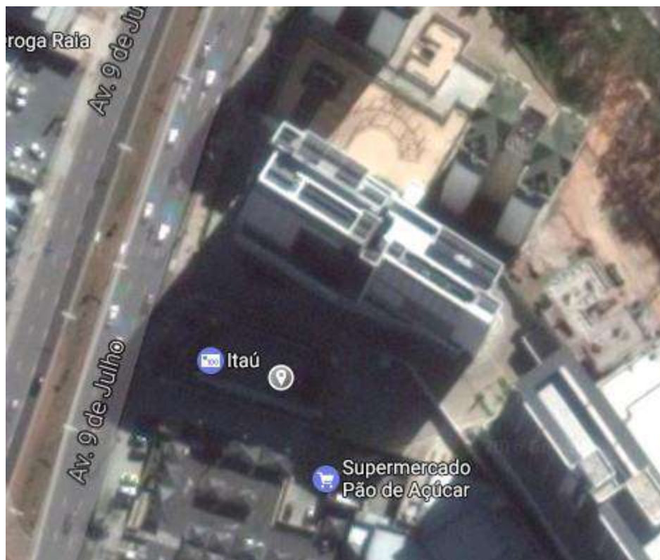
Figura 36 - Exemplo de Agência de Banco com sombra ao norte, inviabilizando o telhado.
