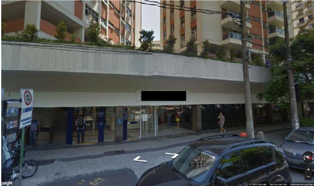
Figura 7 - Exemplo de endereço comercial sem acesso ao telhado.
