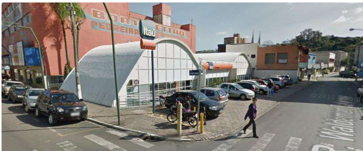
Figura 35 - Exemplo de Agência de Banco com telhado que inviabiliza o projeto.
