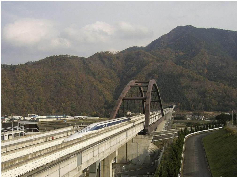
Figura 1- Trem de levitação eletrodinâmica japonês (JR-Maglev, MLX01)
