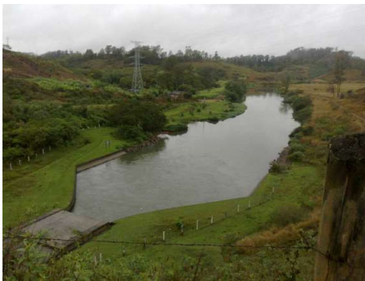
Figura 4.10: Vista de cima da Estação 1: saída do túnel (estrutura de concreto) das águas da UEL Sta. Cecília para o reservatório de Santana.
