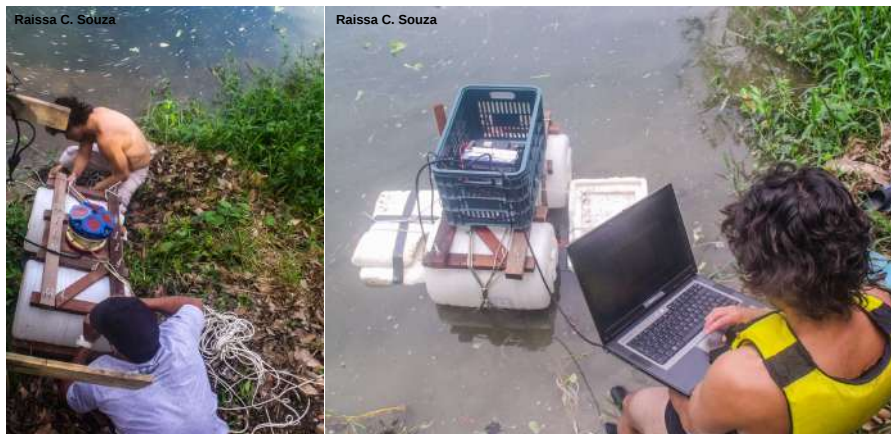
Figura 4.23: Fixação do ADCP na balsa Papillon (foto à esquerda) e acomodação dos periféricos (bateria e computador) na caixa organizadora (foto à direita).
