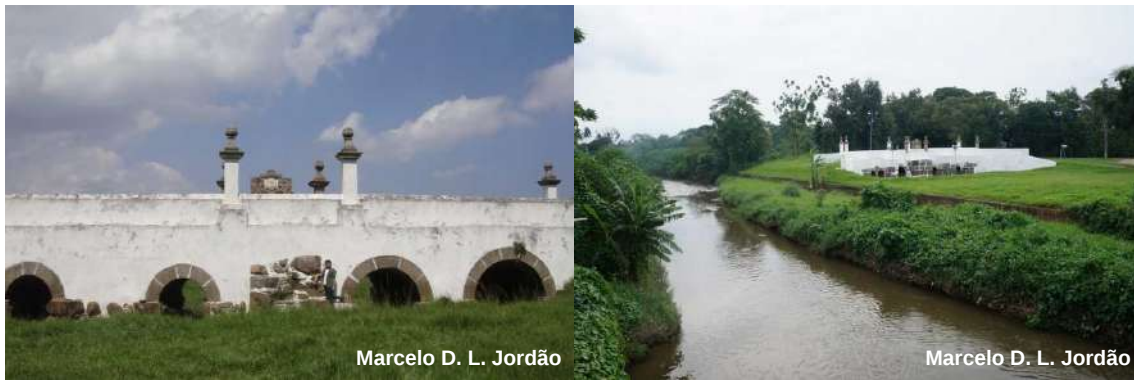
Figura 2.38: Detalhe em escala (altura da pessoa = 1,65 m) dos arcos da ponte dos jesuítas do lado jusante e vista a montante da ponte ao lado do rio Guandu mirim. Fotos tiradas em 08/03/2016.
