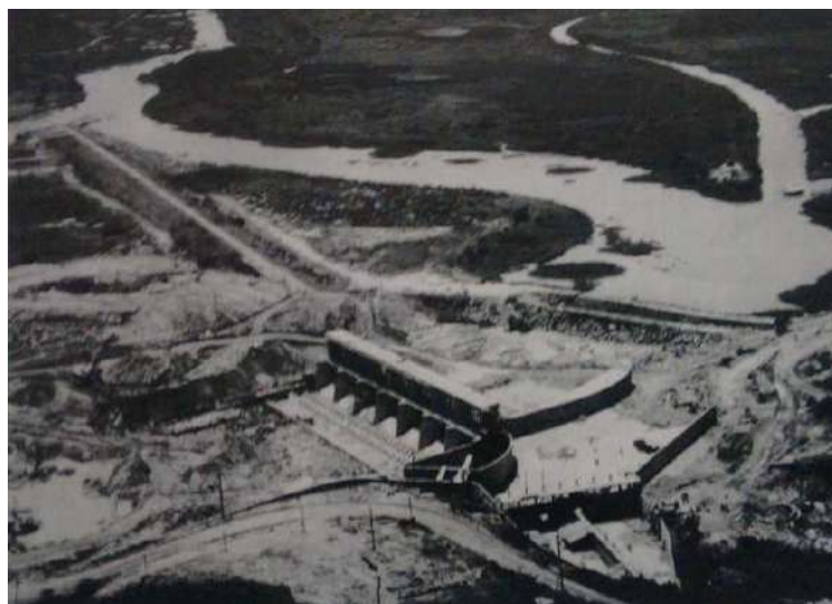
Figura 2.53: Foto sem datação da construção da barragem para captação da ETA-Guandu, concluída em 1965. Foto extraído de RITTA (2009).
