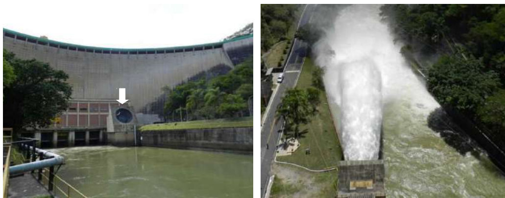
Figura 5.32: Teste da válvula difusora na UHE Funil em 18/11/14 durante 3 horas (11:00 - 14:00). Seta branca apontado a saída do difusor. Foto tirada por Marcelo Roberto Rocha de Carvalho.
