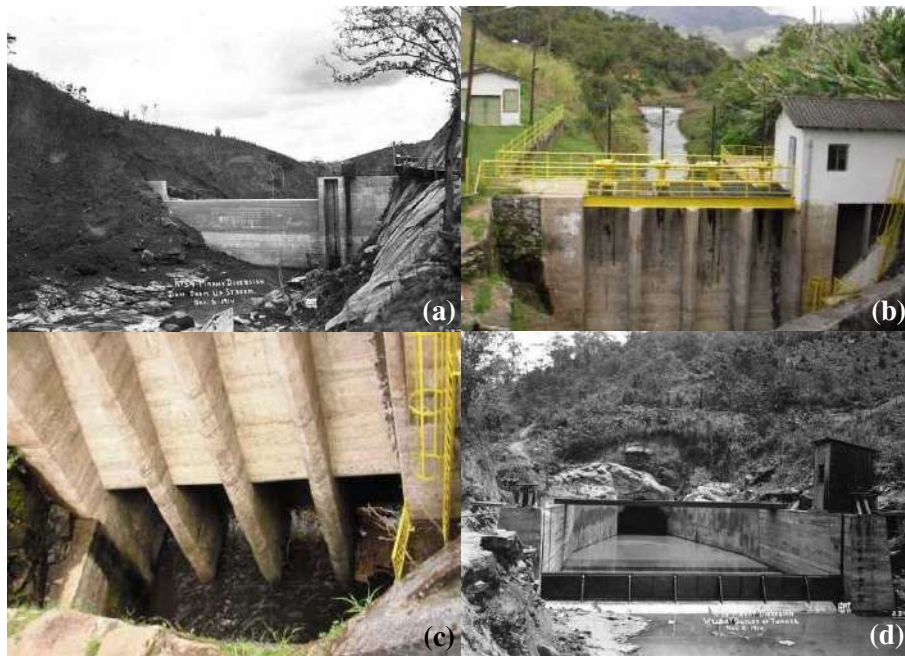
Figura 3.4: (a) Barragem de Tocos, foto tirada em 1914 (extraído de CBDB (2011)). (b) Entrada do túnel de Tocos, foto tirada em 2011 (extraído de SEA-PROJECTS (2011)). (c) Detalhe das 4 comportadas da entrada do túnel de Tocos, foto tirada em 2011 (extraído de SEA-PROJECTS (2011)). (d) Desembocadura do túnel de Tocos, foto tirada em 1914 (extraído de CBDB (2011)).
