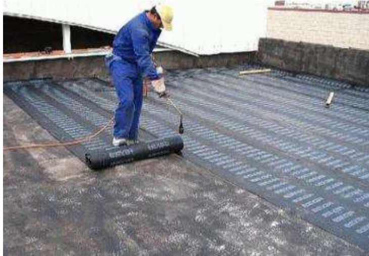
Figura 72 – Aplicação da manta asfáltica impermeabilizante em uma laje.
