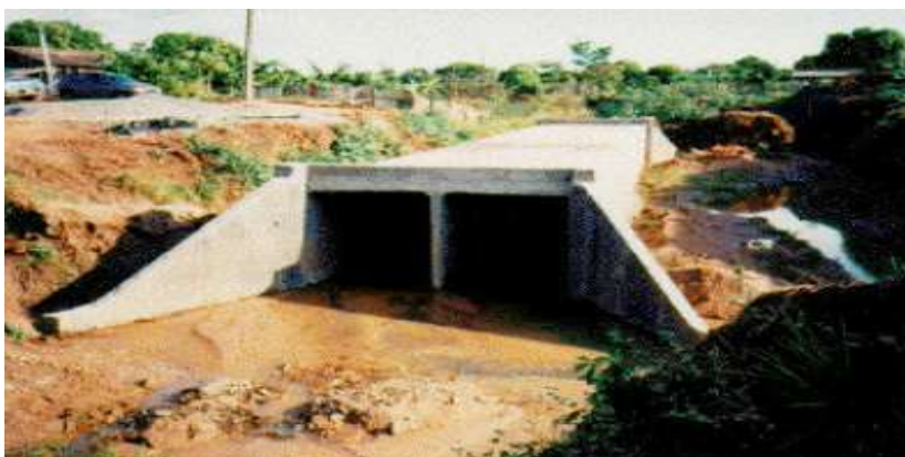
Figura 26 – Galeria de Concreto Armado. (FONTE: MORALES, 2003)
