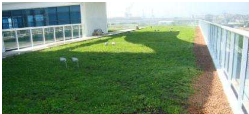
Figura 62 – Foto do telhado da empresa Schlumberger, na cidade do Rio de Janeiro, Brasil.
