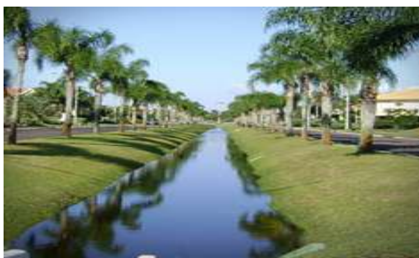
Figura 29 – Foto de uma vala de infiltração.
