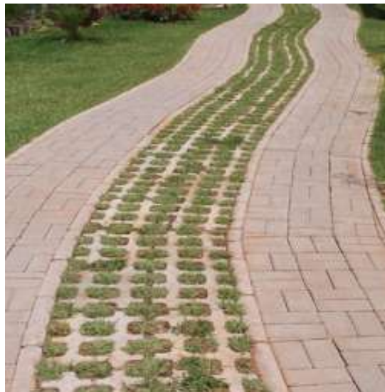
Figura 33 – Pavimento permeável utilizado em calçadas.
