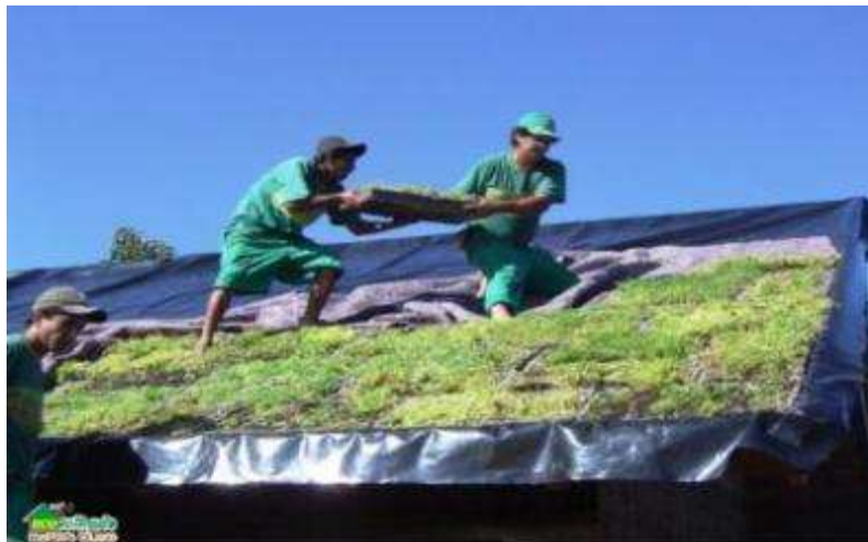
Figura 87 – Aplicação do sistema modular em uma cobertura. (FONTE: http://www.ecotelhado.com.br/ , acesso em 2011)
