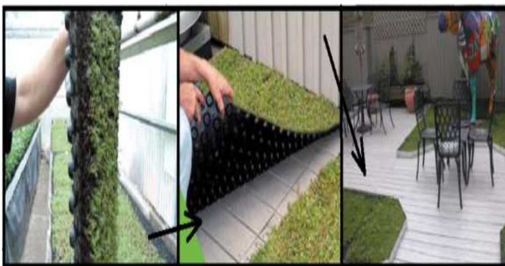
Figura 90 – Sistema da manta vegetativa pré-cultivada aplicada em uma cobertura residencial.
