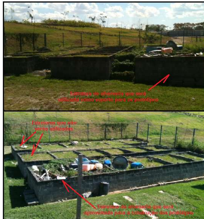
Figura 124 – Fotos do local onde serão construídos os protótipos. Detalhe para as paredes de alvenaria já existentes que servirão de suporte para os protótipos.
