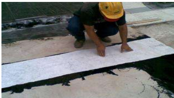
Figura 76 – Aplicação do Geotêxtil.
