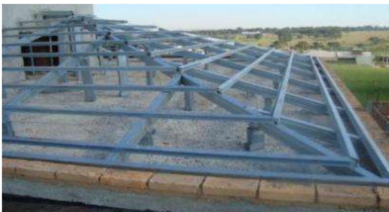
Figura 67 – Telhado com estrutura metálica.
