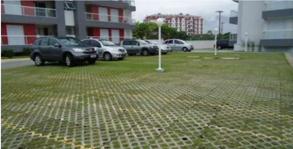
Figura 32 – Pavimento permeável utilizado em estacionamento.
