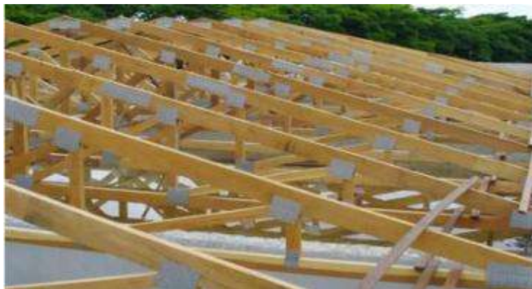
Figura 65 – Telhado com estrutura de madeira.
