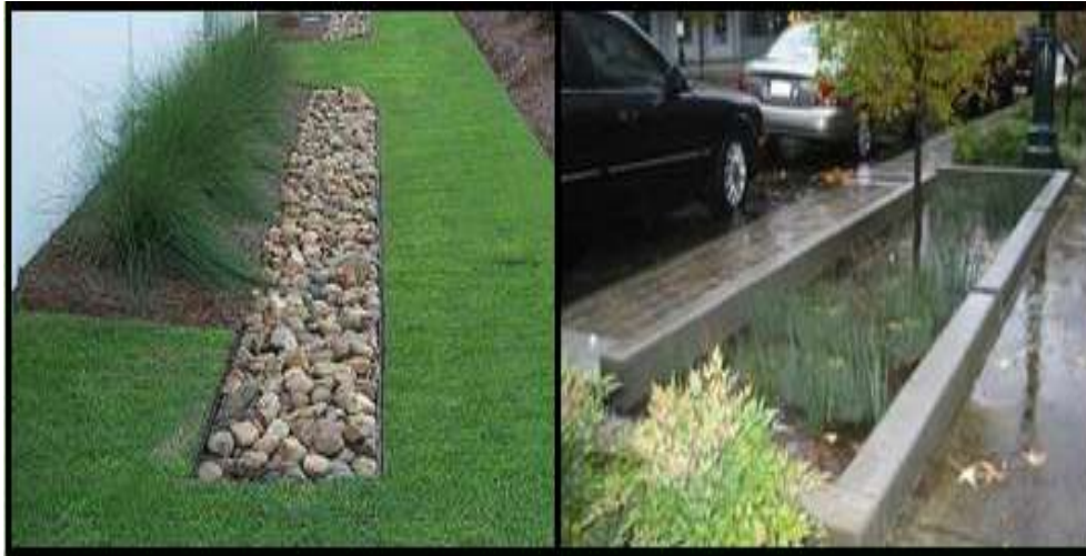
Figura 30 – Trincheiras de infiltração.
