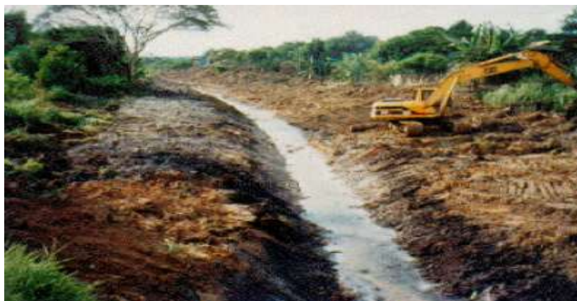
Figura 25 – Retificação de Canal Natural. (FONTE: MORALES, 2003)
