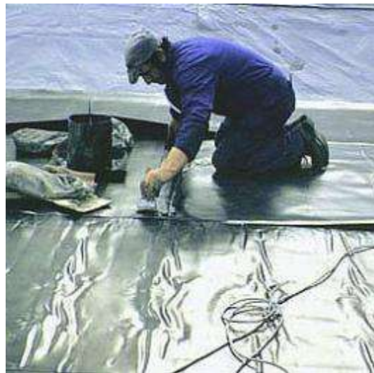
Figura 70 – Aplicação da manta impermeabilizante de PVC em uma laje.
