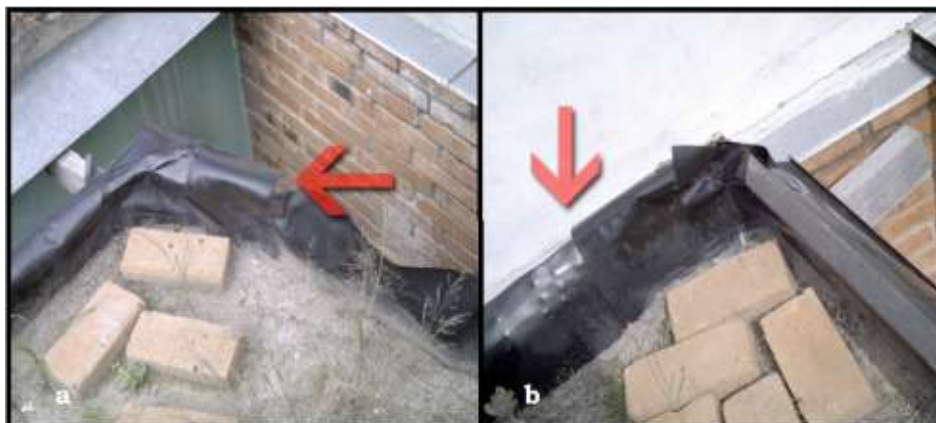
Figura 94 – Recortes da manta nas bordas: (a) e sobreposição da manta (b) executadas in loco . (FONTE: KREBS; SATTLER, 2010)
