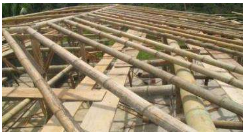
Figura 66 – Telhado com estrutura de bambu.
