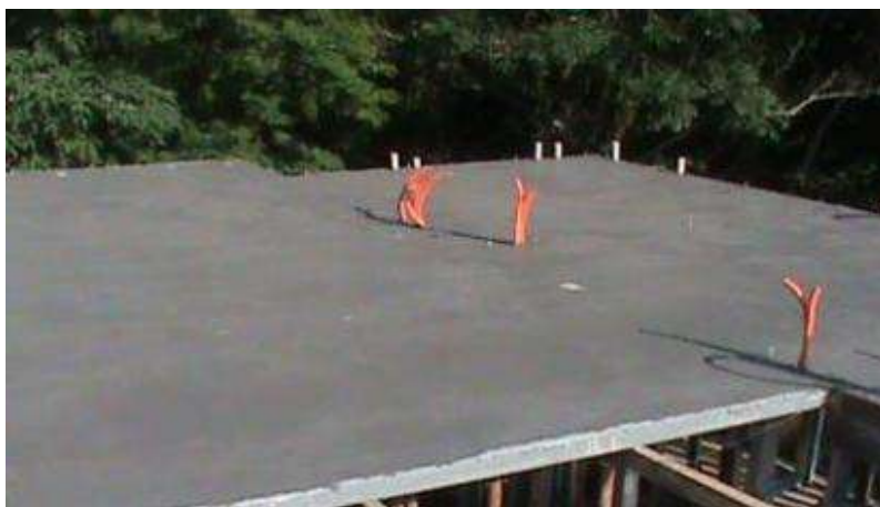
Figura 68 – Cobertura com laje de concreto armado.
