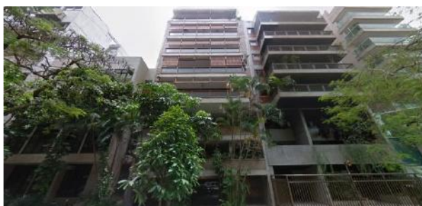
Figura 162: Fachada (Rua Alberto de Campos, 250). Fonte: Google Street View, nov., 2017.
