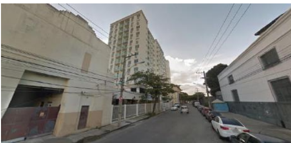
Figura 57: Fachada (Rua Mons. Manoel Gomes, 143). Fonte: Google Street View, jul., 2017.
