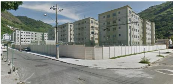
Figura 81: Fachada (Rua da Pátria, 573). Fonte: Google Street View, Abril, 2017.
