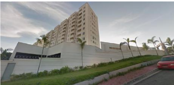
Figura 85: Fachada (Rua Monte Santo, 200). Fonte: Google Street View, maio, 2017.
