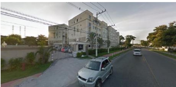
Figura 129: Fachada (Est. Joao Paulo, 745). Fonte: Google Street View, Abril, 2017.
