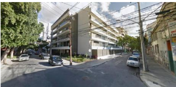
Figura 65: Fachada (Rua Duque de Caxias, 39). Fonte: Google Street View, jul., 2017.
