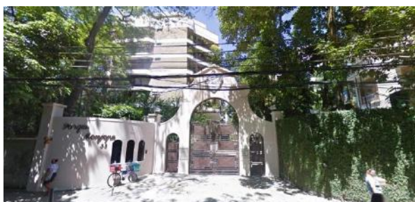
Figura 170: Fachada (Rua General Tasso Fragoso, 33). Fonte: Google Street View, nov., 2017.
