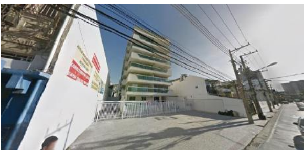
Figura 61: Fachada (Rua Barão de Mesquita, 787). Fonte: Google Street View, maio, 2017.
