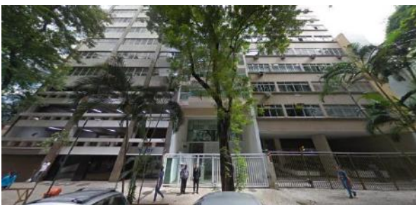
Figura 45: Fachada (Rua Barão de Itambi, 58). Fonte: Google Street View, mar., 2017.
