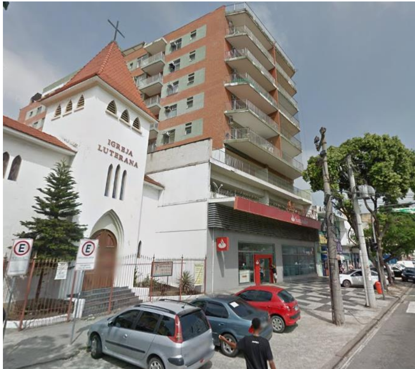
Figura 15: Edificação com embasamento no alinhamento e torre com cinco pavimentos afastada das divisas e alinhada com o embasamento, na Penha. Fonte: Google Street View, 2015.
