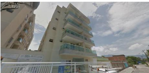
Figura 97: Fachada (Rua dos Estampadores, 152). Fonte: Google Street View, jan., 2017.
