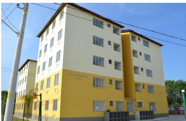
Figura 149: Fachada (Av. Cidade de Deus, 1840). Fonte: Site da Targa Engenharia.
