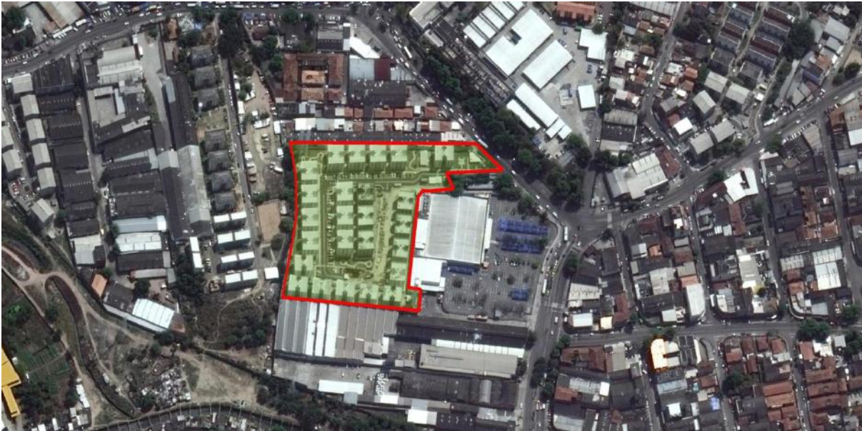
Figura 68: Localização do empreendimento da Av. Itaóca, 1441, Bonsucesso. Fonte: Google Earth, 06/10/2017.
