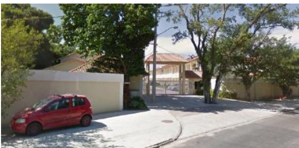
Figura 137: Fachada (Est. do Catruz, 2345). Fonte: Google Street View, Abril, 2016.
