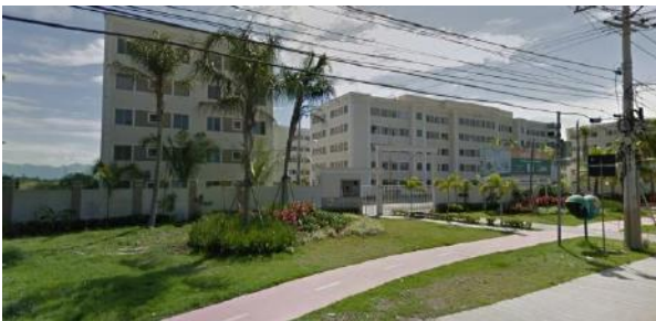
Figura 109: Fachada (Av. P. Guilherme Dec., 1667). Fonte: Google Street View, Maio, 2017.
