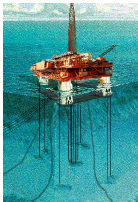
Figura 7 – Plataforma de Pernas Atirantadas _
