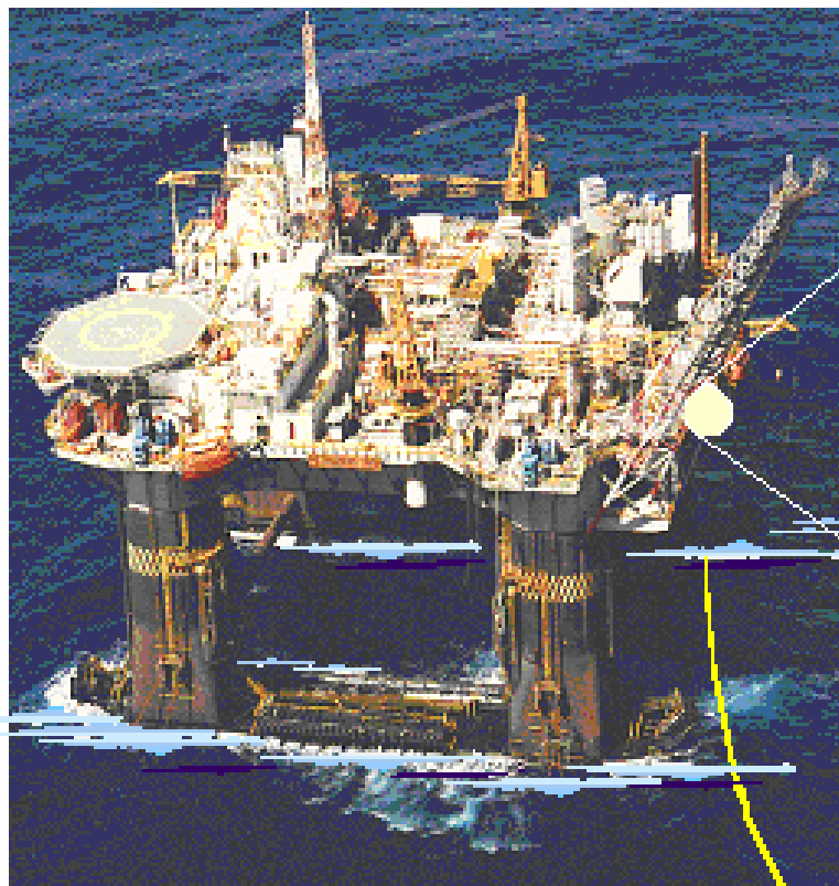
Figura 10 – Plataforma Semi-Submersível PETROBRAS – XVIII
