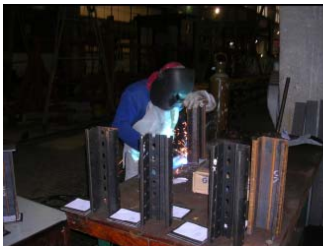
Foto 11 - Centragem dos corpos nas chapas de extremidade.
