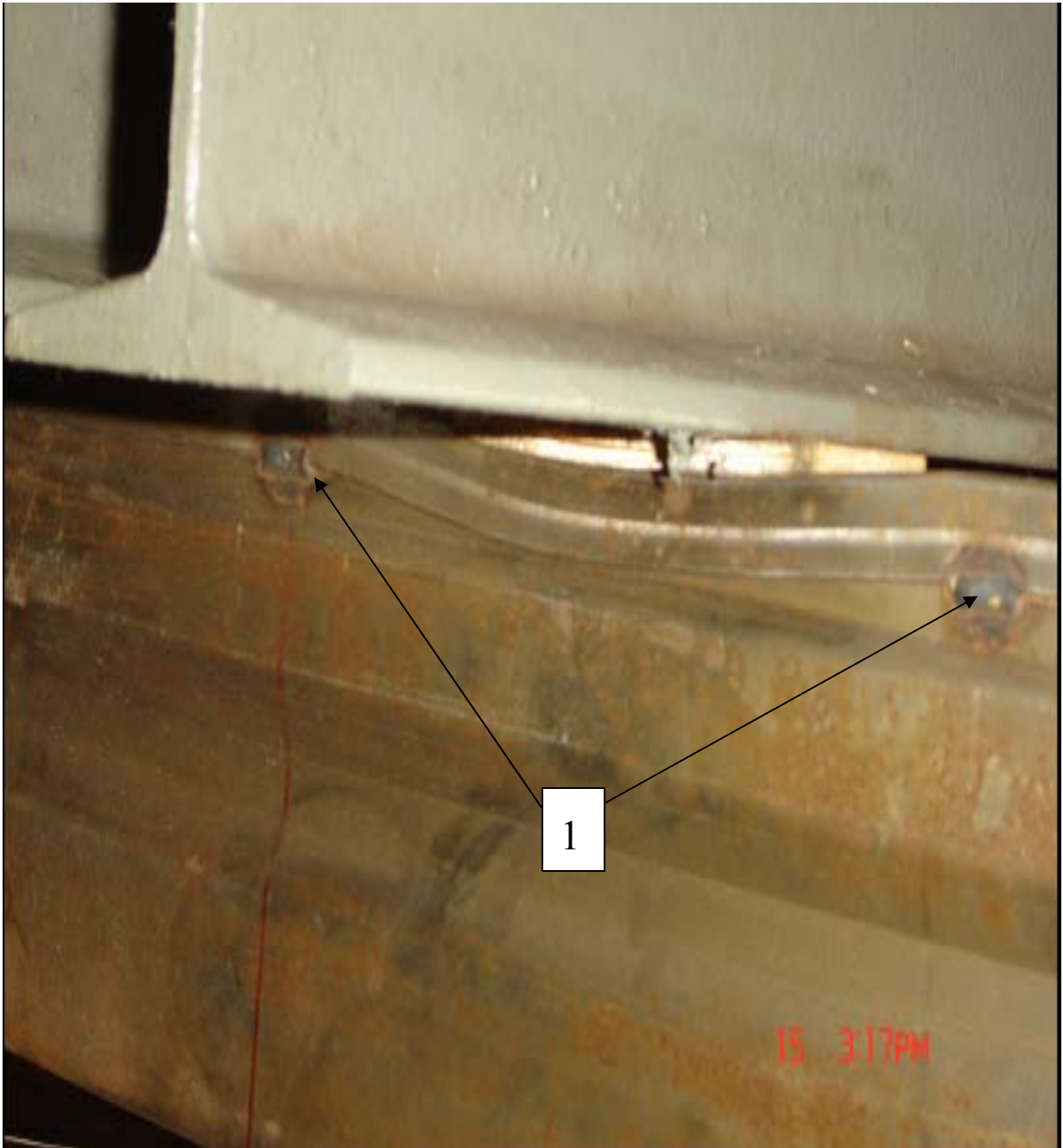
Foto 8 - Esmagamento da mesa: 1 - Configuração de soldagem.
