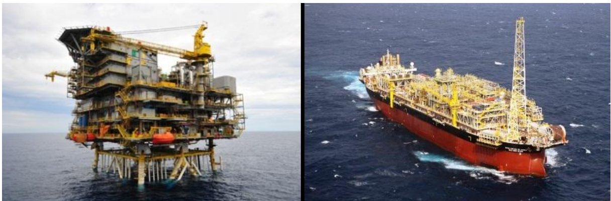
Figura 4.2 Na esquerda, a plataforma fixa PMXL-1 de Mexilhão, à direita, o FPSO Cidade de Angra dos Reis do bloco BM-S-11 [27].
