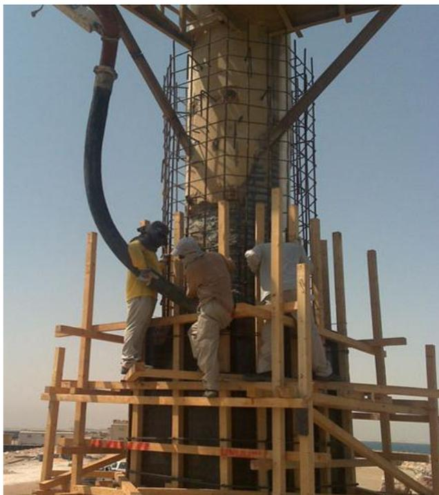
*Figura 16. Encamisamento de um pilar com concreto armado.*
