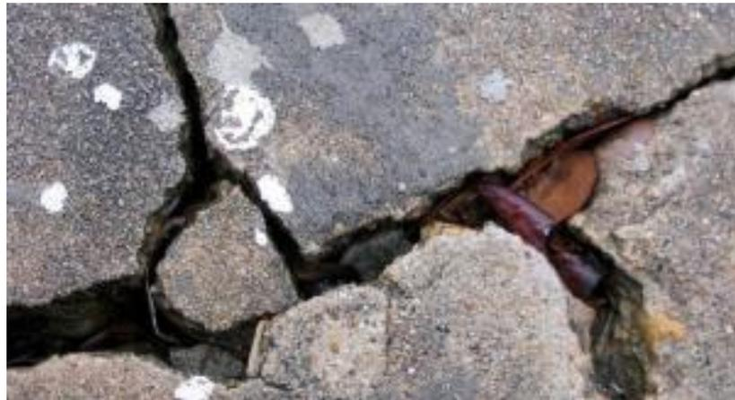
*Figura 2. Fenda no tabuleiro de uma ponte.*
