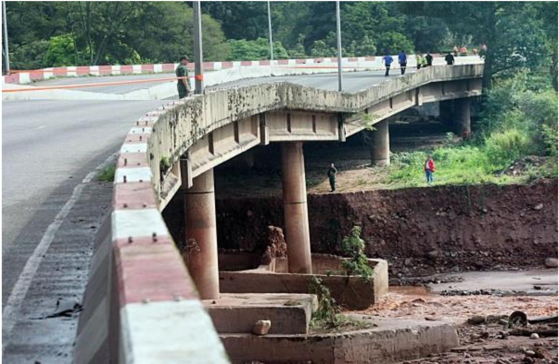
Figura 6. Ponte com fundação colapsada [Disponível em <http://www.lanacion.com.ve>].
