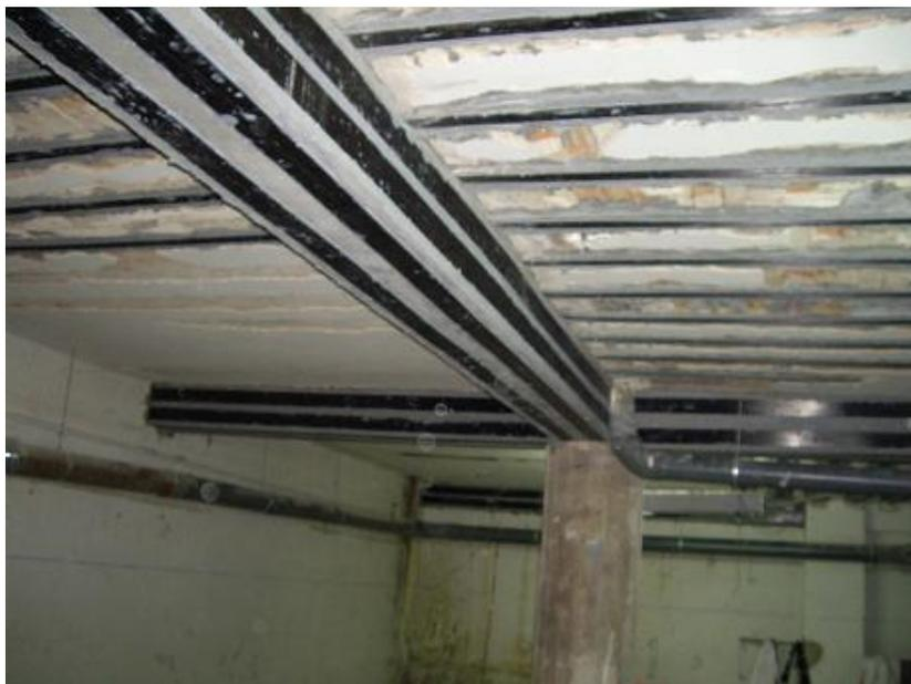
*Figura 25. Reforço à flexão com fibra de carbono. [Disponível em <http://www.grupodagal.com>].*
