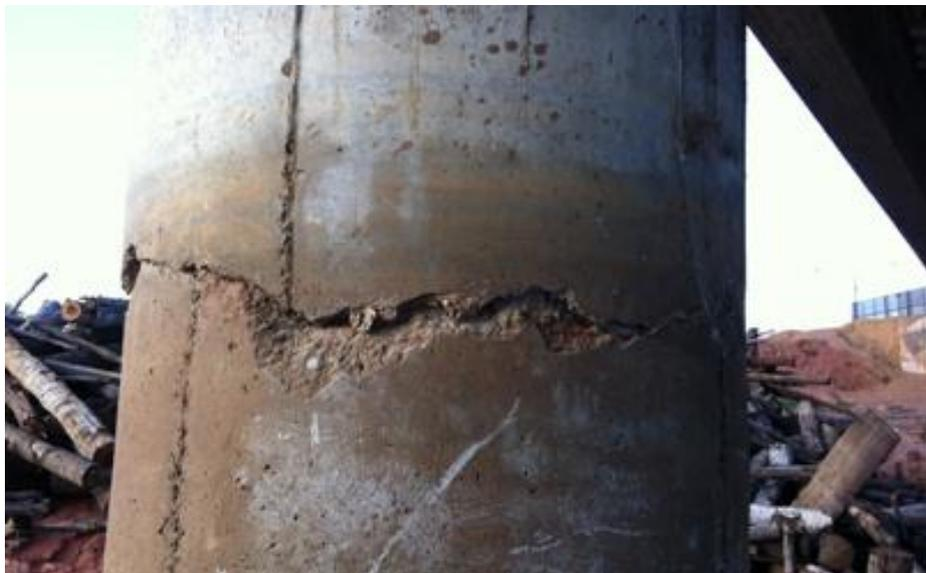
*Figura 9. Colapso de uma ponte por falha nas sustentações. [Disponível em <http://www.portalonorte.com.br>]*
