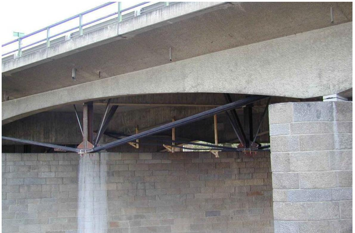
*Figura 28. Ponte com protendido exterior de reforço. [Disponível em <http://www.fcp.at>].*
