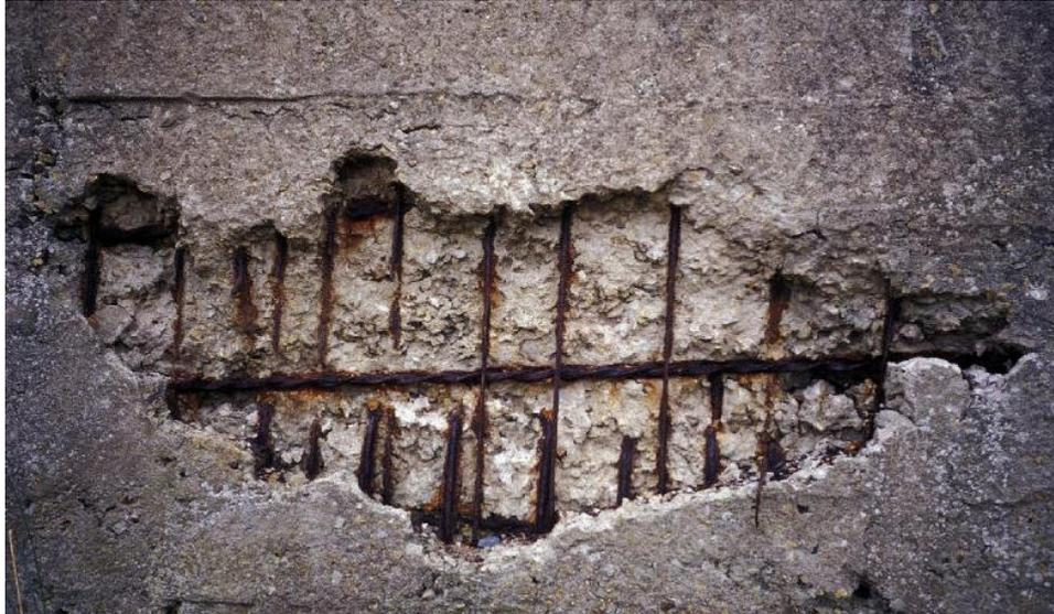
*Figura 5. Perda de recobrimento nas armaduras.[Disponível em <http://diegomallof.blogspot.com.br>].*
