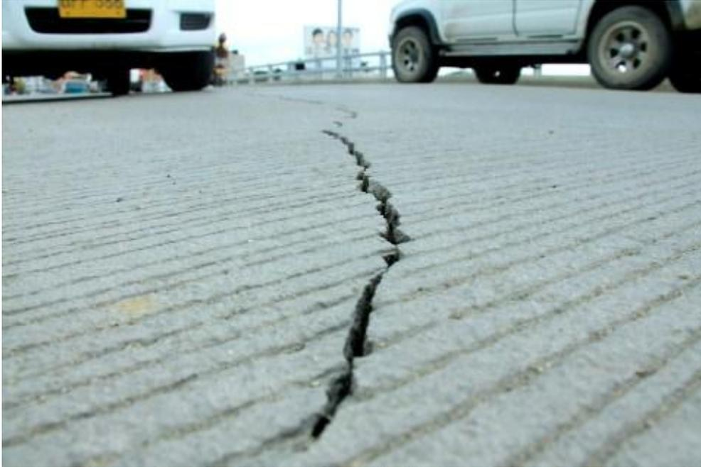
*Figura 12. Deterioração da estrada. [Disponível em <http://www.scielo.cl>].*
