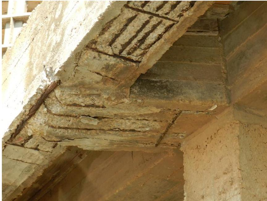
*Figura 11. Corrosão de armaduras de aço.[Disponível em <http://www.enriquealario.com>].*
