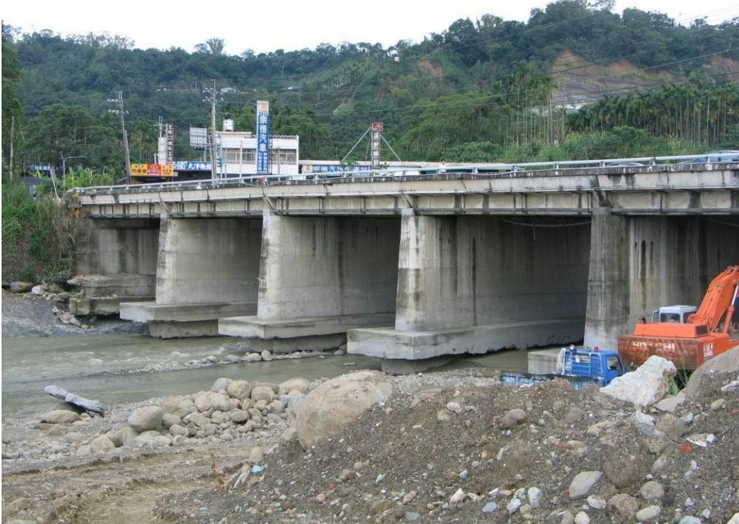
*Figura 7. Pilares erodidos por ação da água.[Disponível em <http://ingeosolum.blogspot.com.br>].*
