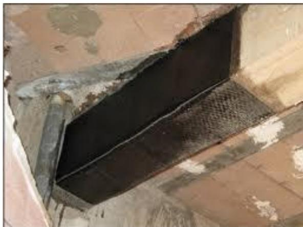
*Figura 26. Reforço de confinamento. [Disponível em <http://www.medconstruccion.com>].*
