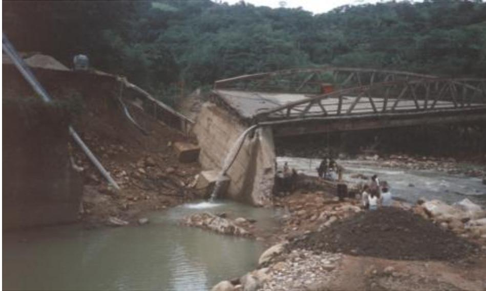
*Figura 8. Colapso de uma ponte por deslizamento do encontro.*
