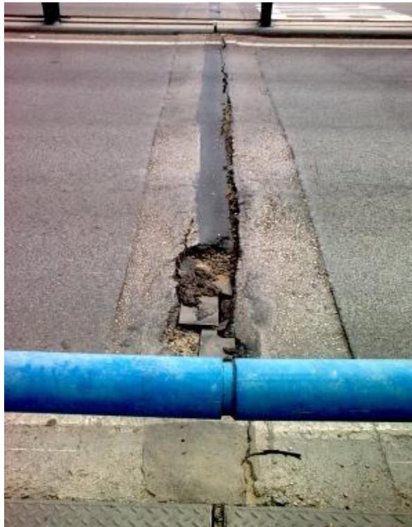
*Figura 10. Desgaste ou ausência de material na junta. [Disponível em <http://www.scielo.org.ve>].*
