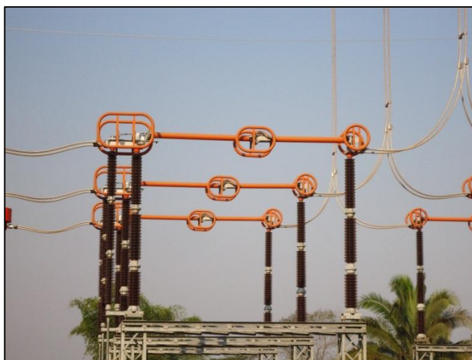
Figura 2.15: Chave Secionadora 500 kV INSD7-15 da SE Itacaiúnas
