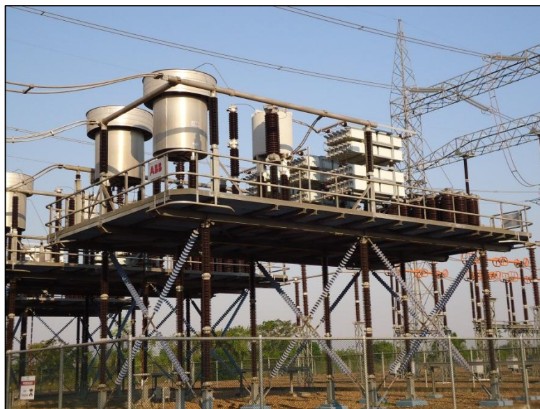
Figura 2.7: Uma das fases do banco de capacitores série INCL7-01 associado a LT 500 kV Colinas - Itacaiúnas
