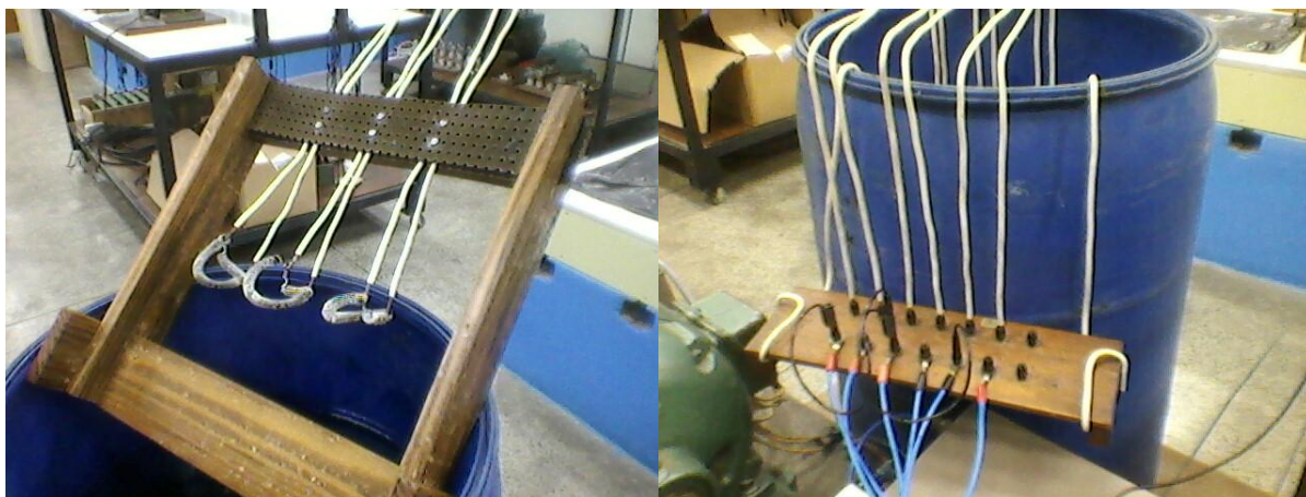
(a) Suporte de madeira com as resistências (carga); (b) Régua de Bornes de madeira para interligação entre a carga e os terminais do estator do alternador
