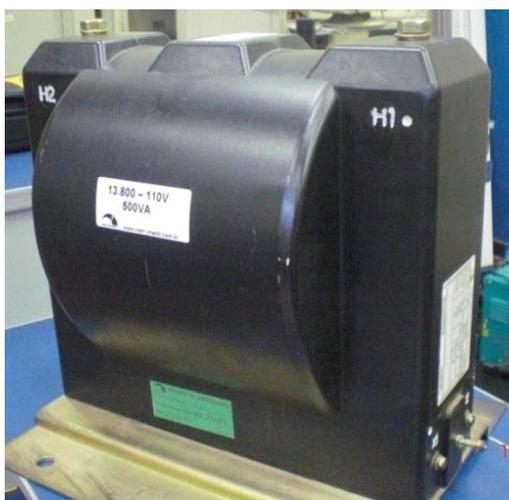
Figura A.2.1: TP - Transformador de potencial
