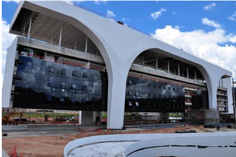
Figura 2.2 – Estrutura de um edifício (Palácio do Governo de Minas Gerais, em fase de acabamento).
